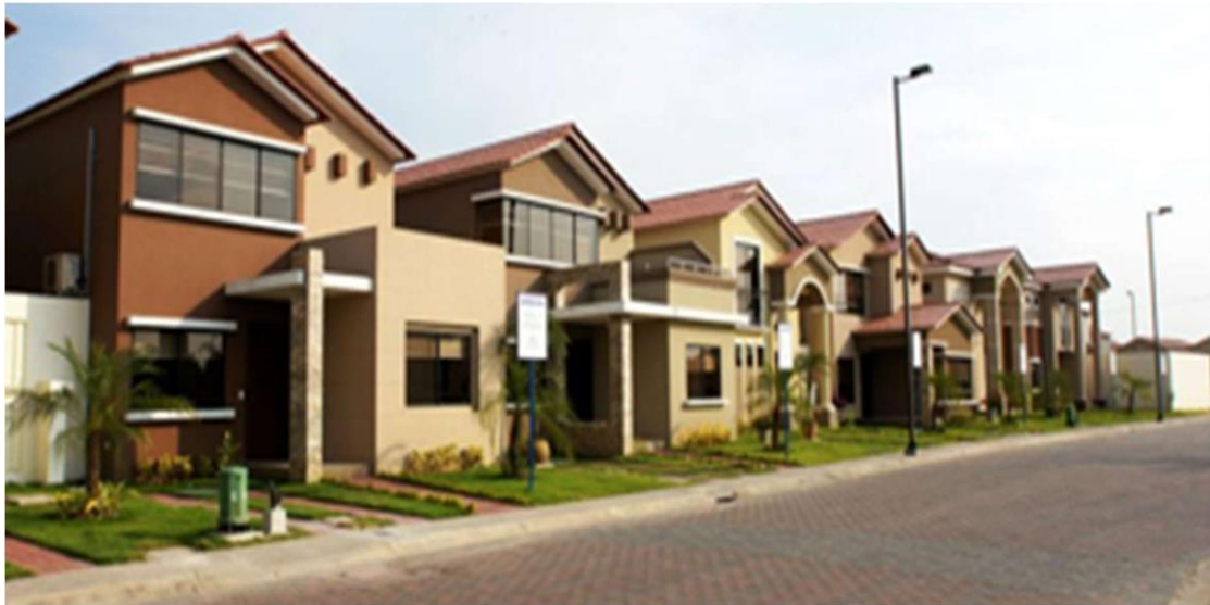
Figura 61 Espacio periférico. Recuperado de: http://www.eymacr.com/servicios3.html
