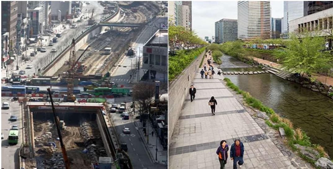
Figura 67 Rehabilitación. Recuperado de: https://obrasweb.mx/arquitectura/2018/02/09/asi-fue-como-seul-derribo-una-autopista-para-recuperar-un-rio
