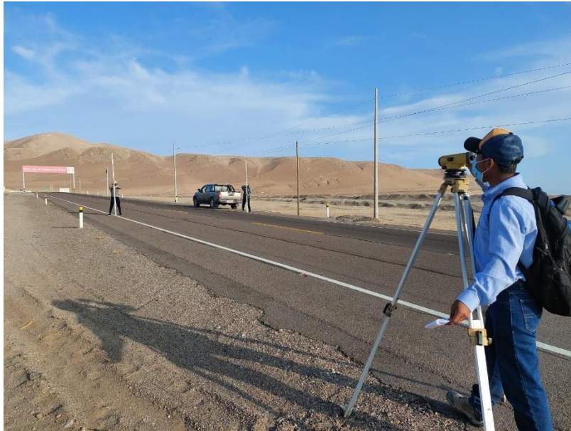
Figura 8: Inicio de levantamiento altimétrico con Nivel de Ingeniero en el KM 39+000 de la Carretera Interoceánica Sur.
