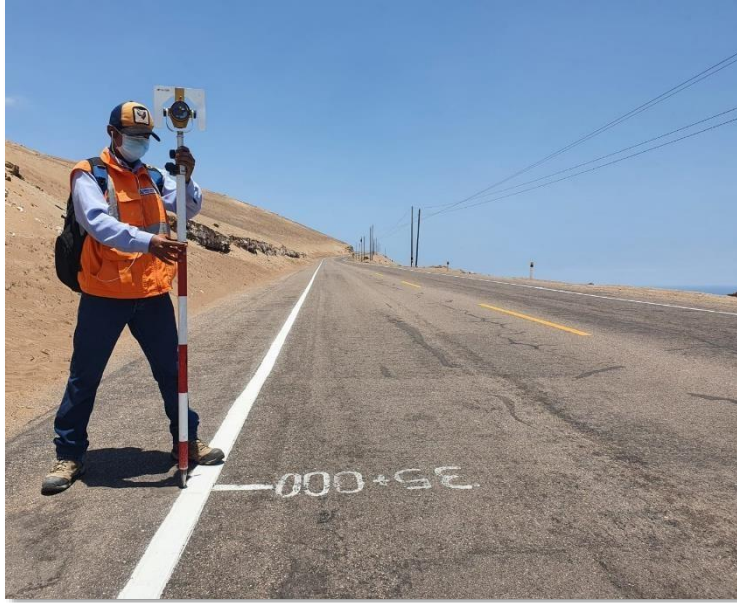
Figura 14: Medición de las coordenadas de la progresiva 35+000 km
