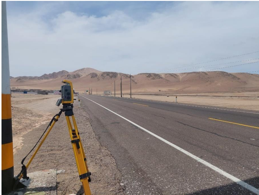
Figura 13: Jornada de levantamiento con Estación Total.
