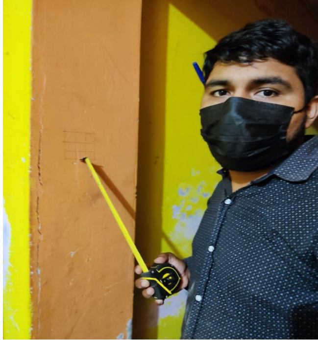
FOTO 9: Procedimiento para ensayo de esclerometría en Col. 02 de la vivienda ubicada en Psje. Ramón Castilla Mz. 19 Lt. 15.
