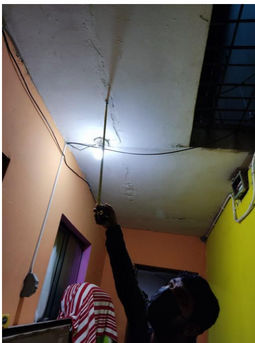
FOTO 19 y 20: Fisuras en techos de las viviendas del A.H. Miraflores Bajo.
