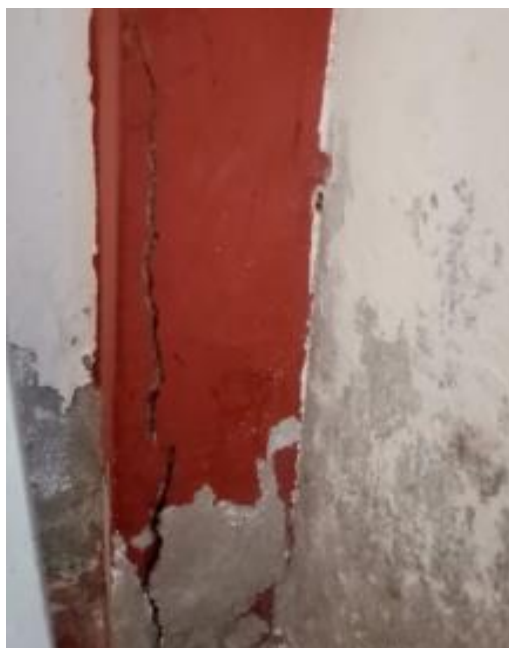
FOTO 17 y 18: Fisuras en columnas de las viviendas del A.H. Miraflores Bajo.
