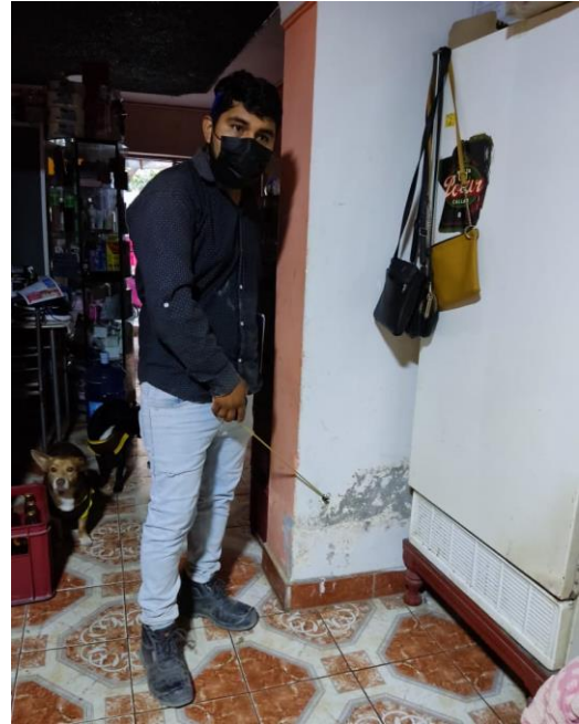
FOTO 21 y 22: Presencia de salitre en las viviendas del A.H. Miraflores Bajo.
