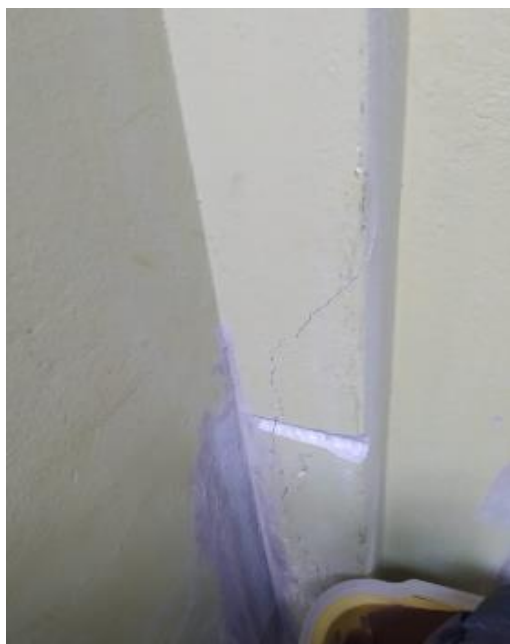
FOTO 17 y 18: Fisuras en columnas de las viviendas del A.H. Miraflores Bajo.
