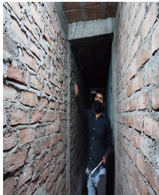
FOTO 23 y 24: Uso de ladrillos de mala calidad en las viviendas del A.H. Miraflores Bajo.
