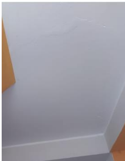
FOTO 19 y 20: Fisuras en techos de las viviendas del A.H. Miraflores Bajo.
