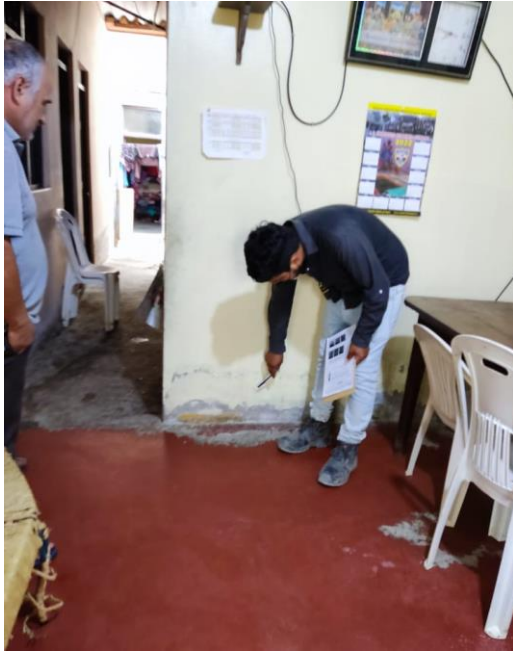
FOTO 21 y 22: Presencia de salitre en las viviendas del A.H. Miraflores Bajo.
