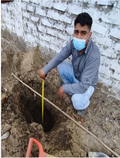
FOTO 5 y 6: Medición y extracción de muestra de la calicata C – 3.
