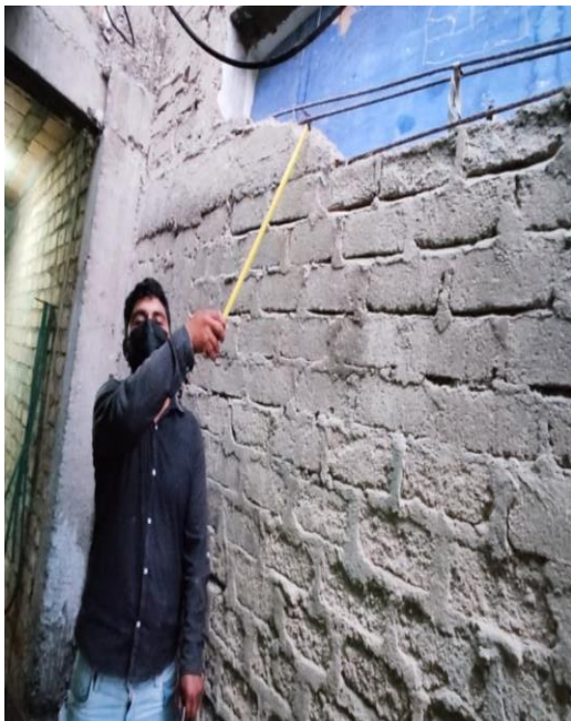
FOTO 23 y 24: Uso de ladrillos de mala calidad en las viviendas del A.H. Miraflores Bajo.
