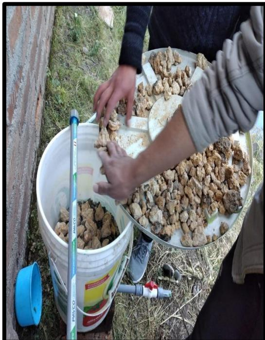
Anexo 16. Realizando la prueba hidráulica en el tanque de almacenamiento, regulador de caudal y filtro percolador de piedra pómez.
