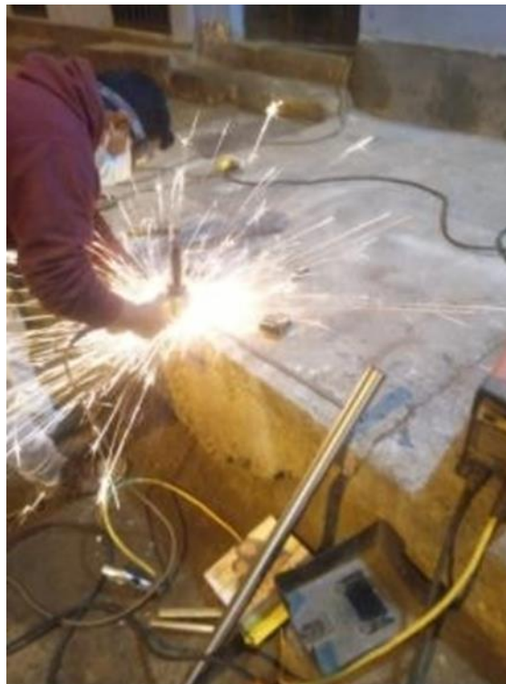
Figura 70. Soldadura de los tubos cuadrados y tubo de acero inoxidable
