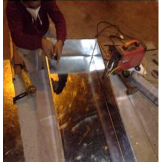
Figura 57. Soldadora inverter electrodo 250Amp para unir los laterales
