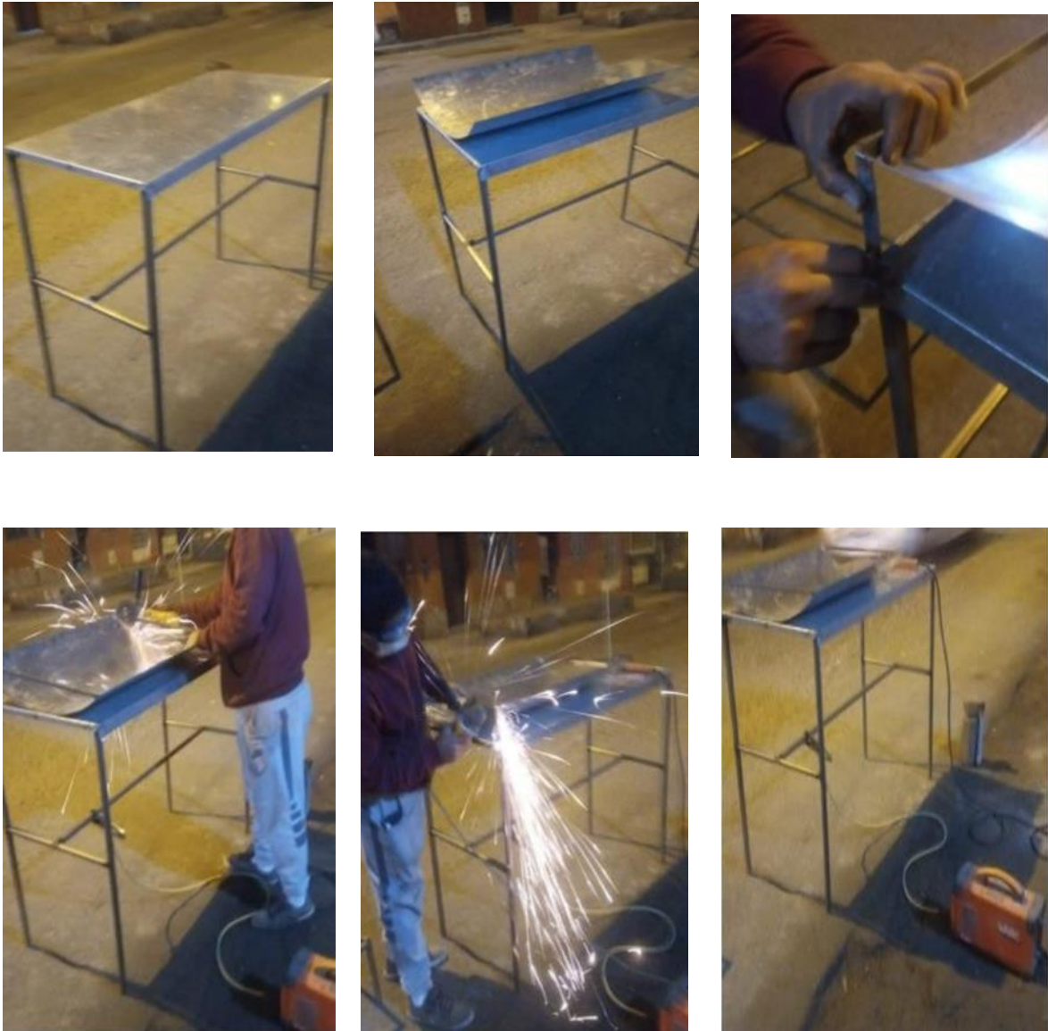
Figura 71. Armado del canal parabólico y la mesa de soporte
