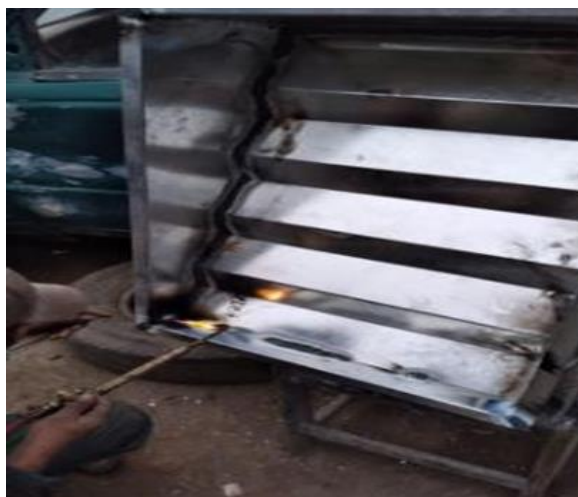
Figura 60. Soldadura autógena para unir los lados de la caja interior, escaleras escalonadas y las láminas de 0.3 cm de altura que van al final de cada escalera.
