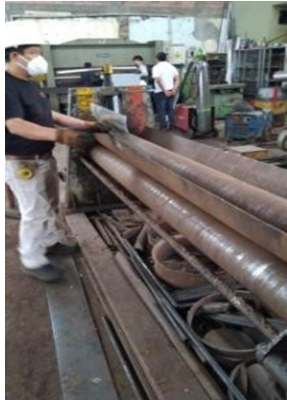
Figura 68. Rolado de la plancha galvanizada con la roladora manual.
