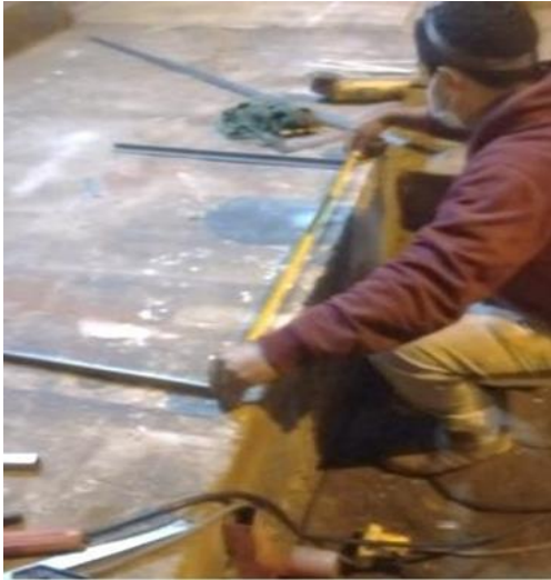
Figura 61. Se midió el tubo cuadrado y ángulo para la base exterior del destilador
