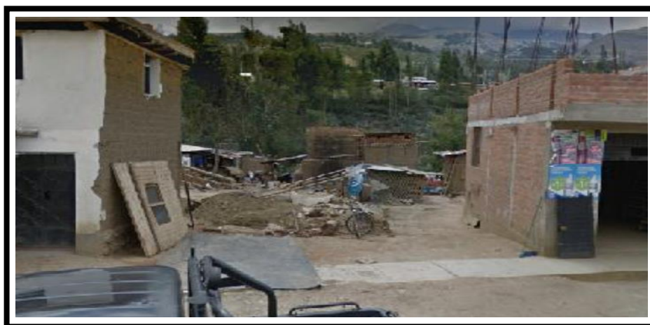
FOTOGRAFIA 2. Fábrica ladrillera dentro de la ciudad de Huaraz. Fuente: Propia del autor.
