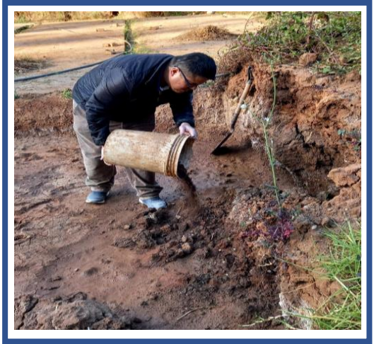
FOTOGRAFIA 3 y 4. Agregación de la tierra de chacra en la composición de barro.
