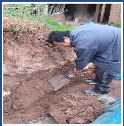
FOTOGRAFÍA 9 y 10. Preparación de ladrillos con la agregación de tierra de chacra
