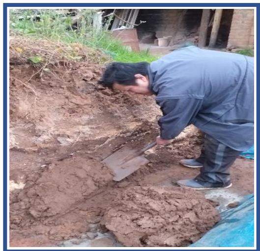
FOTOGRAFIA 5 y 6. Revolviendo con palana y a mano, para lograr una composición uniforme con la tierra de chacra.
