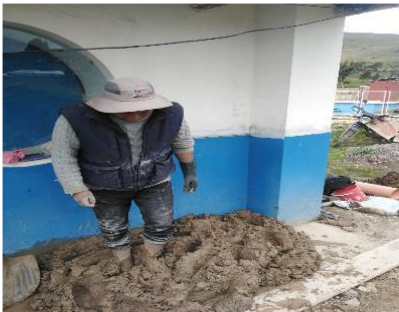
Imagen 21: Mezclado de barro y celulosa de cartón reciclado
