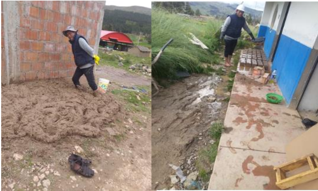
Imagen 60: Proceso de preparado y elaboración de adobe
