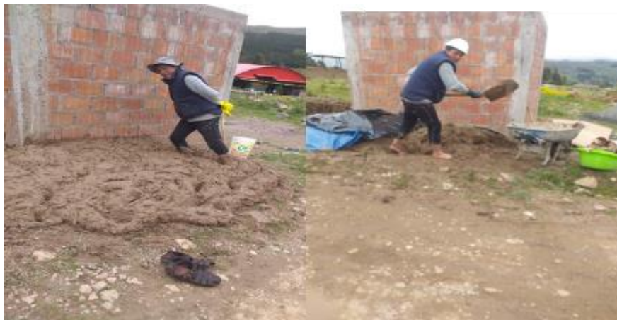
Imagen 15: Pisado y volteado el barro hasta llegar a una mezcla homogénea.
