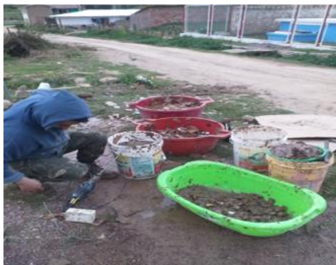
Imagen 13: Desfibrado del cartón en un balde
