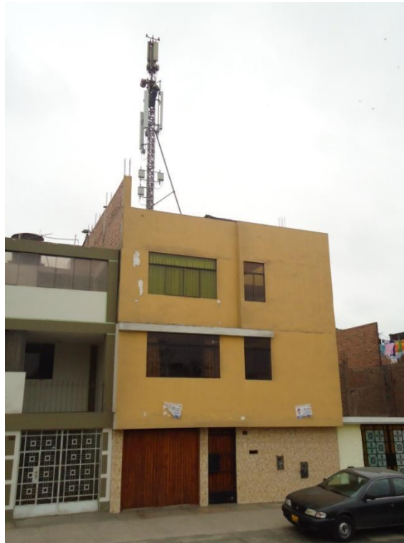
Figura 15. Fachada de la edificación común
