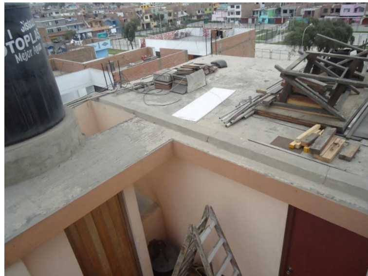
Figura 16. Azotea de la edificación
