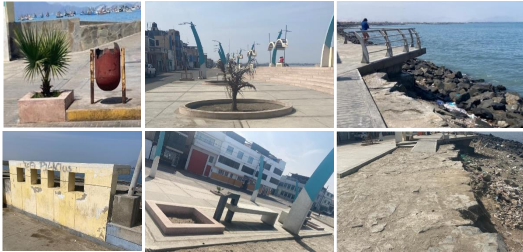
Figura 21: Condición de mobiliarios urbanos
