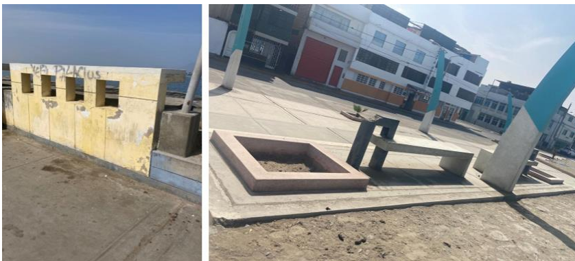
Figura 13::Bancas de concreto armado
