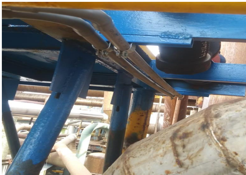
Tendido de tubería PVC-SAP con abrazaderas de 1".
