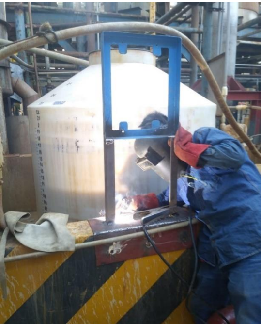
Soldeo y montaje de soporte de tablero
