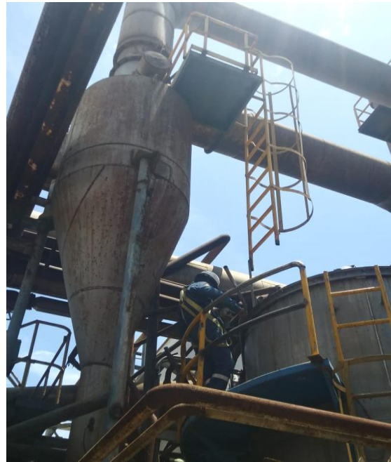
Tendido de tubería en el tanque de lodo de tubería PVC-SAP de 1" alrededor de tanque de lodo
