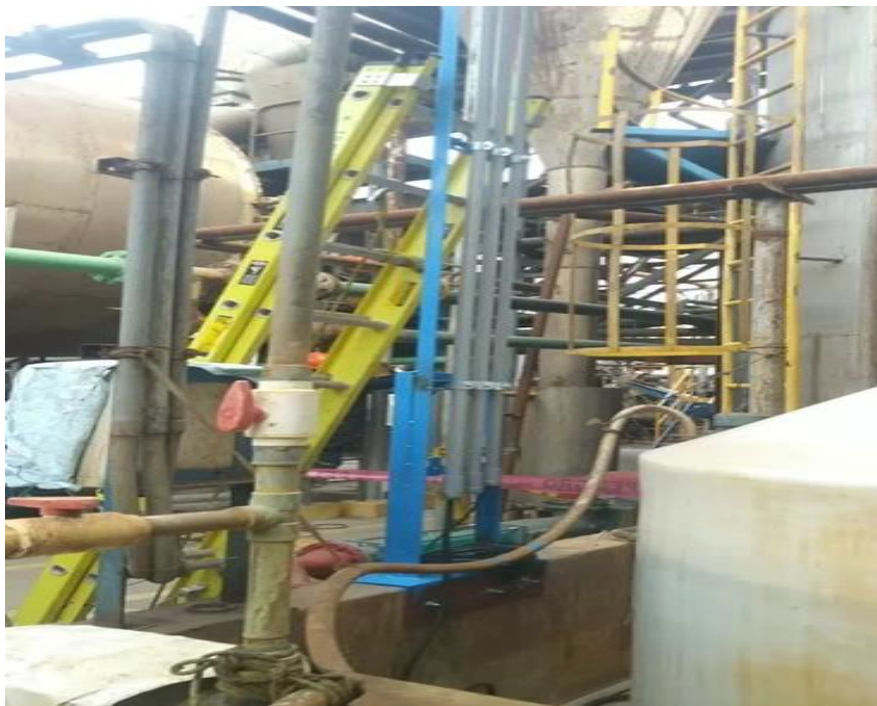
Tendido de tubería PVC-SAP de 1" y \frac{3}{4} " hacia el soporte del tablero eléctrico.
