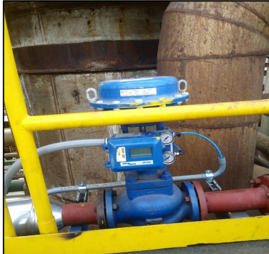
Figura 13. Instalación eléctrica y neumática del posicionador. Fuente: (Elaboración propia)
