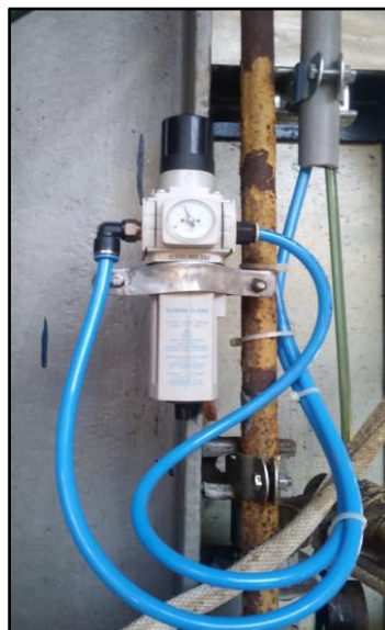
Figura 12. Filtro regulador de aire (FR) Fuente: (Elaboración propia)
