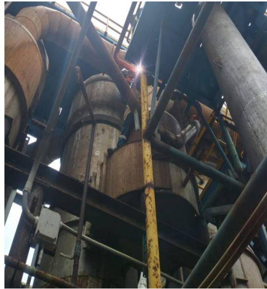
Soldeo de soportaría la salida del posicionador
