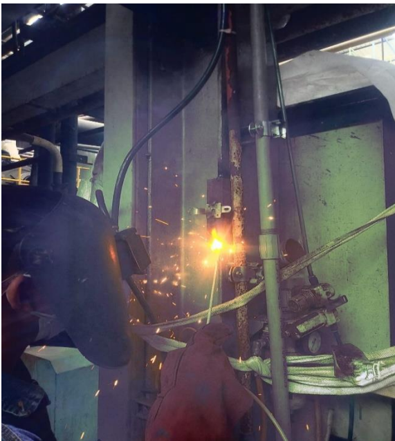
Soldeo de soporte de filtro regulador de aire
