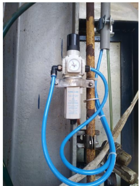
Instalación de filtro regular de aire.
