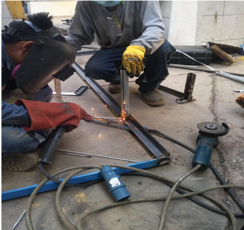
Soldeo de riel unistrunt pesado.
