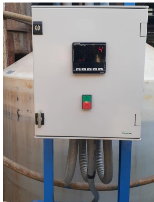
Montaje de soportaría, entubado y tendido de cable para alimentación sensor P100
