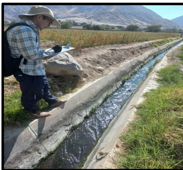
Figura 15 Registro de patologías
