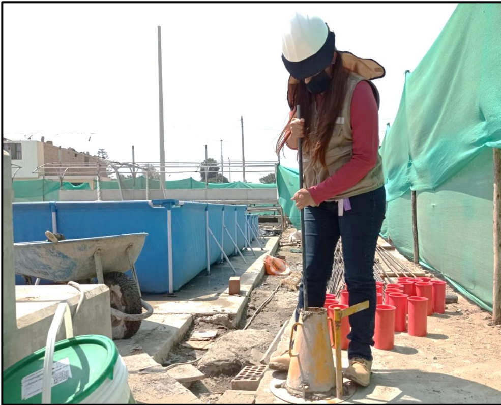
FOTO N° 17: Ensayo del Slump del concreto f'c 210 kg/cm 2 con agua potable.
