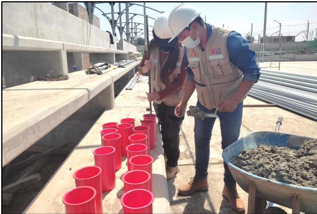
FOTO N° 13: Vaciado de concreto f'c 175 kg/cm 2 y f'c 210 kg/cm 2 con agua residual tratada en moldes de probetas.
