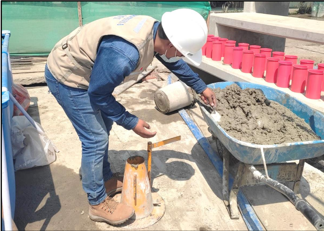
FOTO N° 11: Ensayo del Slump del concreto f'c 175 kg/cm 2 y f'c 210 kg/cm 2 con agua residual tratada.
