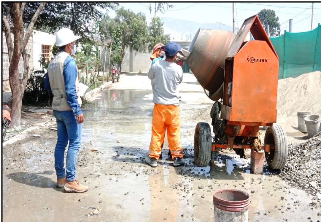
FOTO N° 10: Preparación de la mezcla f'c 175 kg/cm 2 y f'c 210 kg/cm 2 con agua residual tratada.
