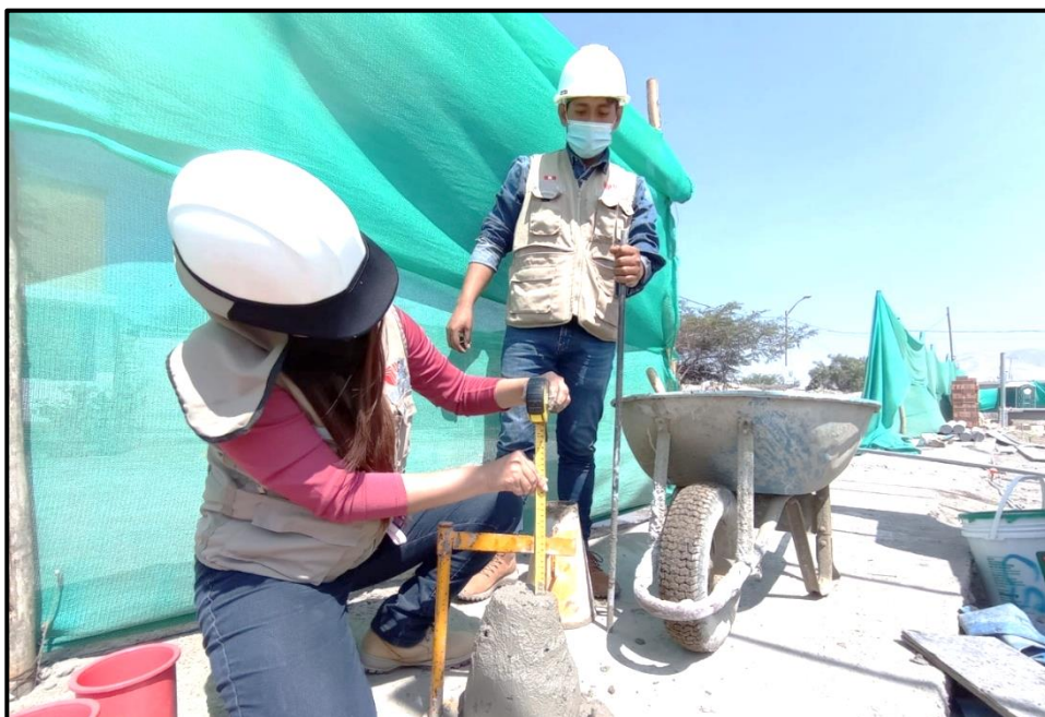
FOTO N° 18: Ensayo del Slump del concreto f'c 175 kg/cm 2 con agua potable.
