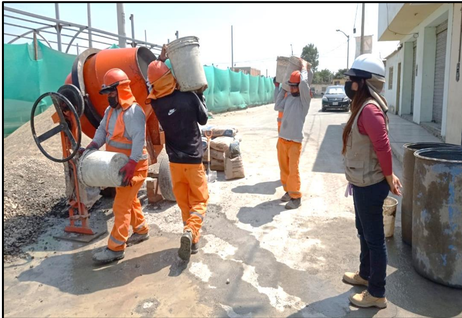
FOTO N° 16: Preparación de la mezcla f'c 175 kg/cm 2 y f'c 210 kg/cm 2 con agua potable.
