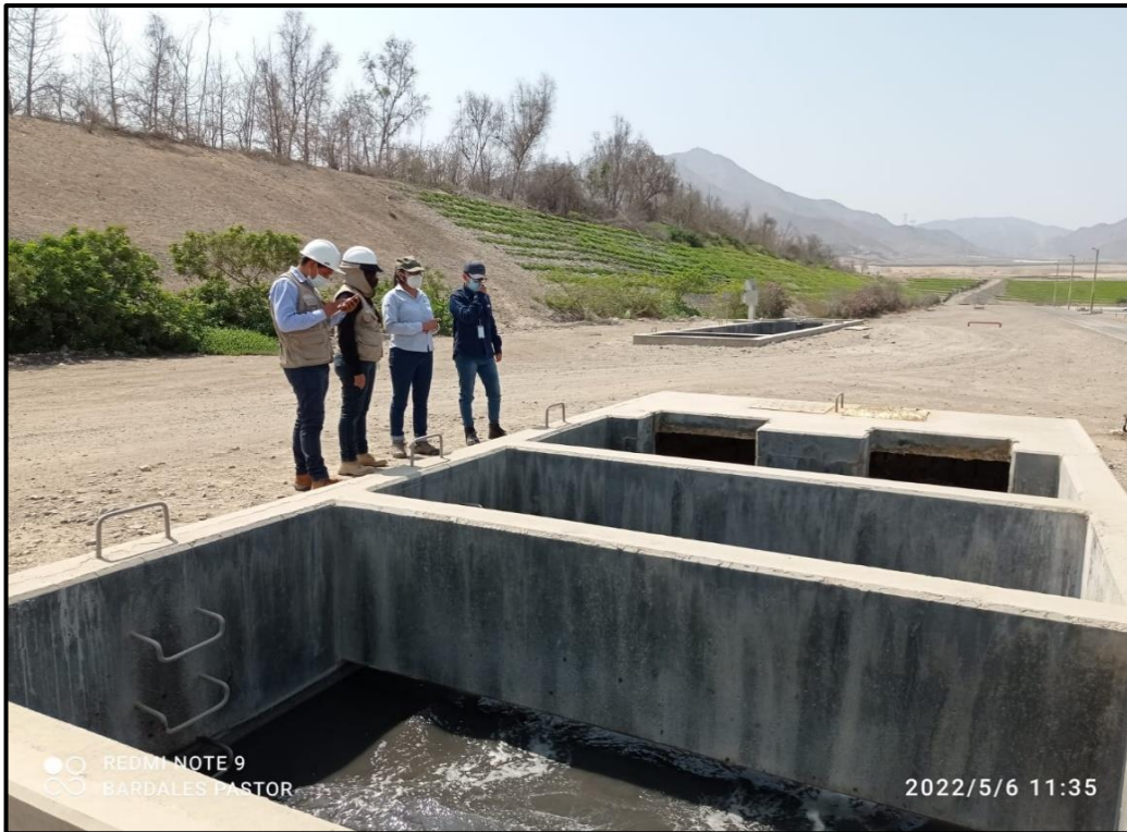
FOTO N° 4: Recorrido a la PTAR San Bartolo.
