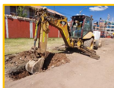
Excavación de calicatas.
