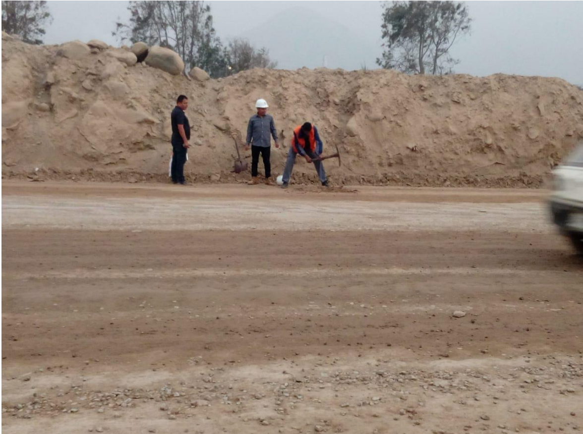
Figura 20. Inicio de la excavación para la calicata
