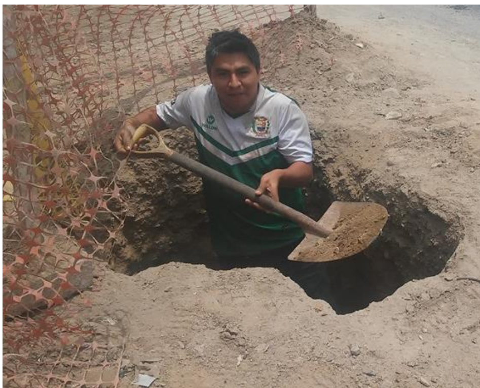
Figura 28. Excavación de la calicata C-01
