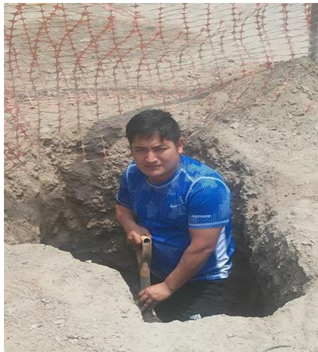
Figura 22. Excavación de la calicata
