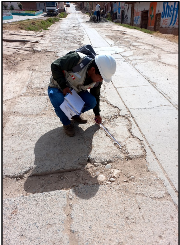
Fotografía 03 y 04: Fallas de losa dividida.
