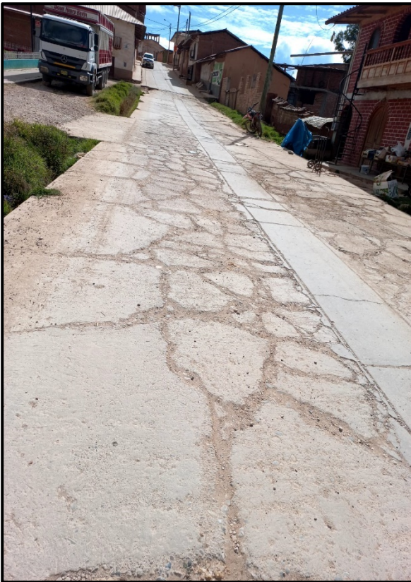
Fotografía 03 y 04: Fallas de losa dividida.
