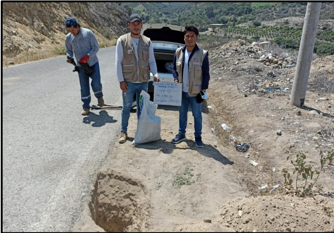
Figura 23: Calicata 3 (profundidad 1.50 m)
