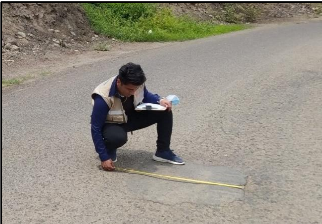
Figura 6: Falla (Parcheo m2)
