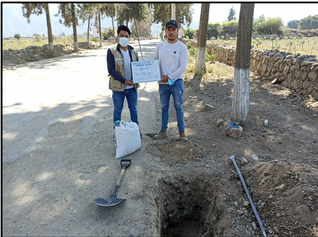
Figura 24: Calicata 4 (profundidad 1.50 m)
