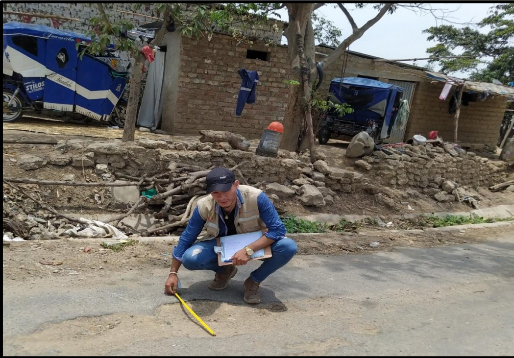
Figura 7: Falla (Huecos m2)
