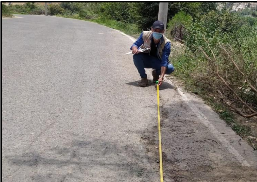
Figura 4: Falla (Grietas de borde m)
