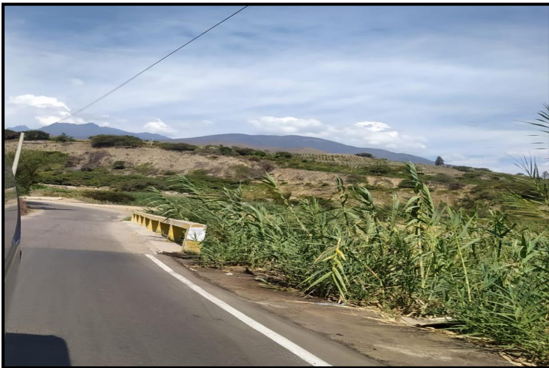
Figura 2: Puente Lampanin - Jimbe
