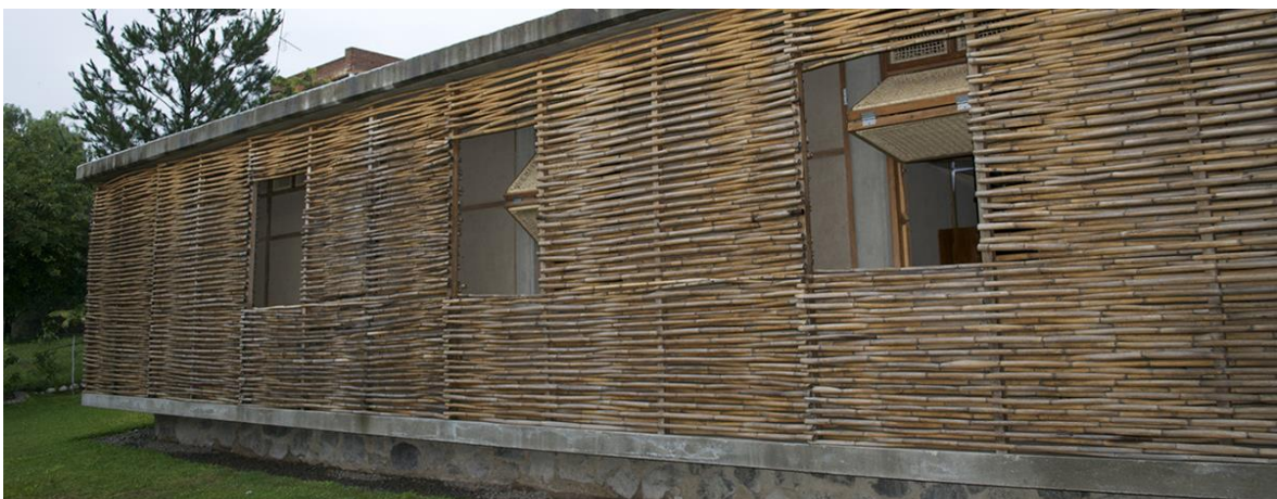
Figura 8 Edificio comunitario en Guadalajara – México
