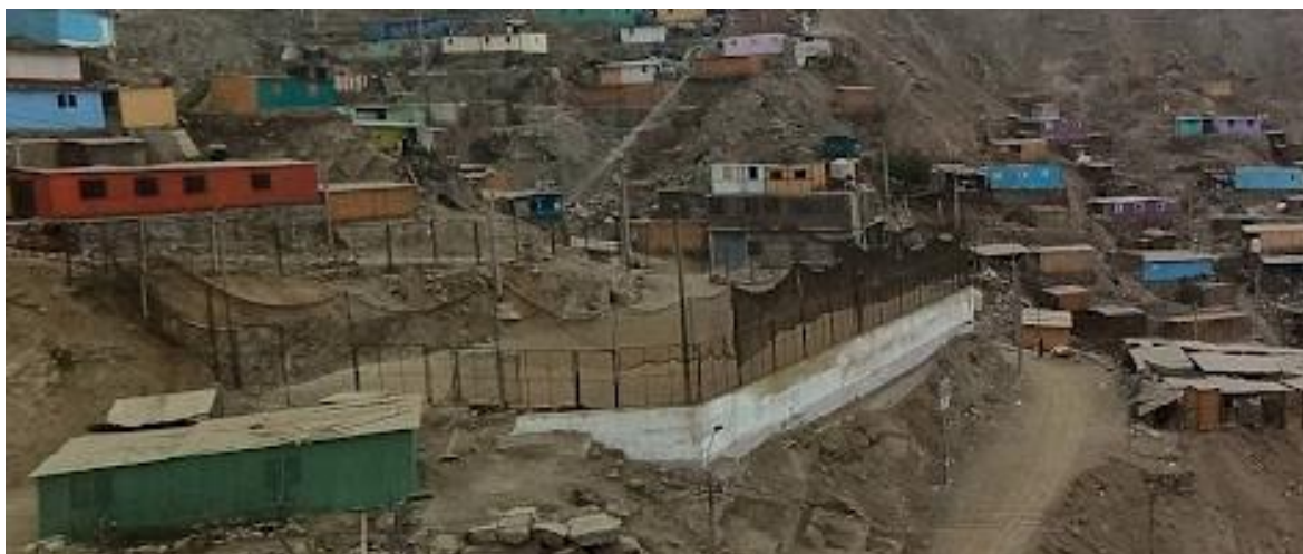
Muro de contención
