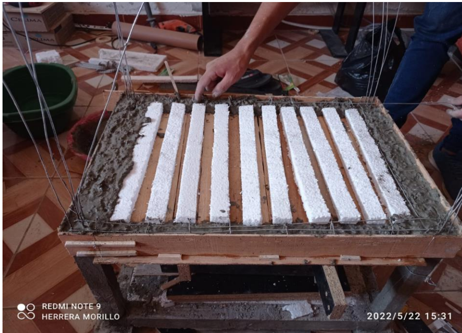
VACIADO DE VIGAS
