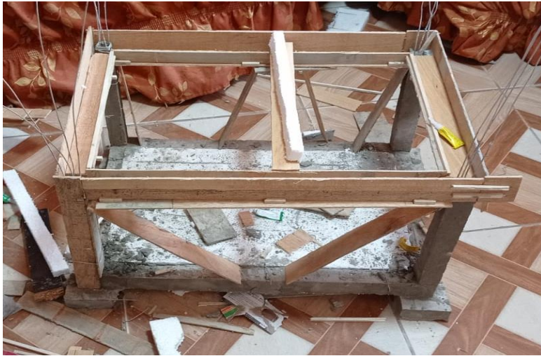
ENCOFRADO DE VIGAS DE MAQUETA
