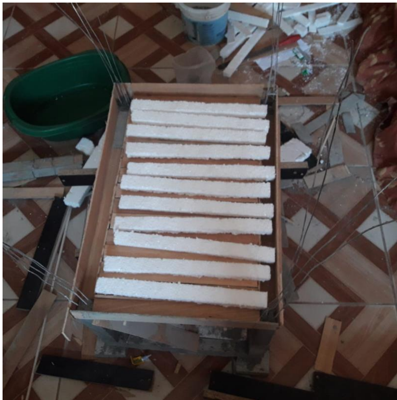
ENCOFRADO DE LOSA DE MAQUETA
