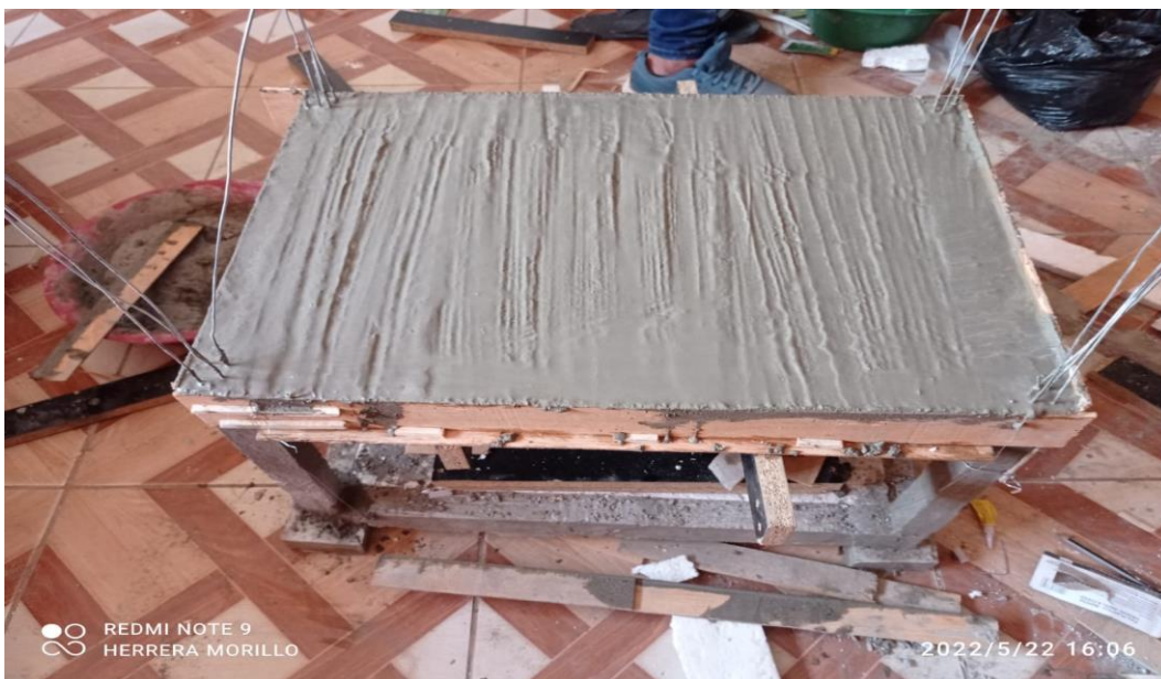
VACIADO DE LOSA DE MAQUETA
