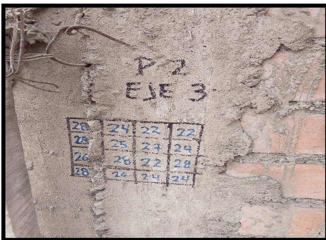
FOTO 29: Punto 02 en columna de esclerometría
