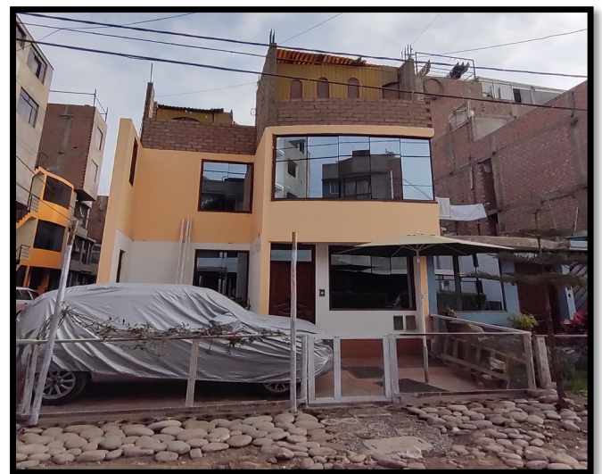
FOTO 24: Vivienda con evidencia de ausencia de viga en el eje corto
