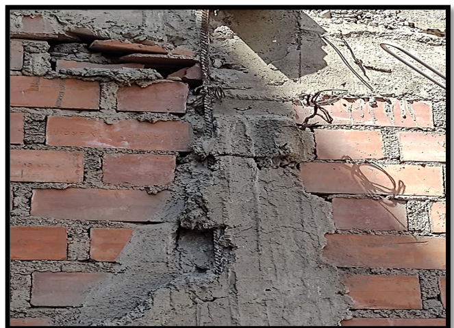
FOTO 4: Cangrejas en elementos estructurales
