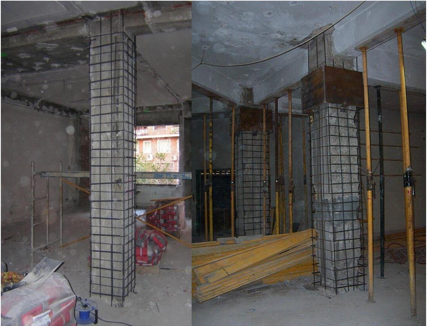
Fuente: Giraldo, Miguel. Encamisado en concreto armado para el refuerzo de vigas y columnas de una edificación.
