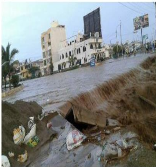
TRUJILLO. Tras el último huaico, el distrito de aHuanchaco quedó en pésimas condiciones. Los vecinos reclaman al alcalde el retiro inmediato del lodo.
