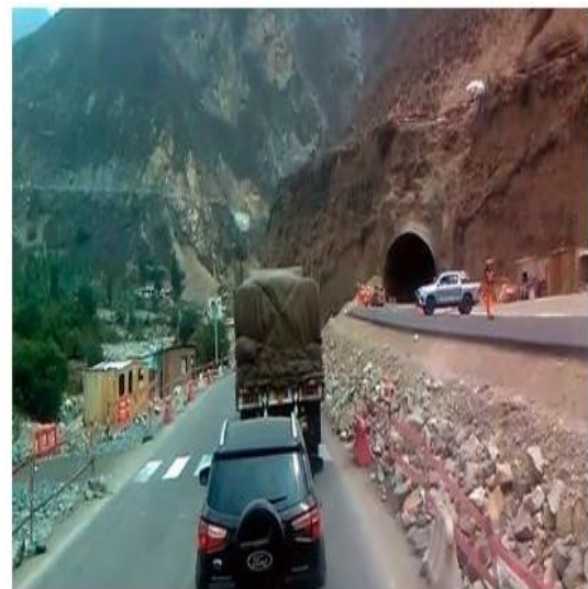
LIMA. El túnel Chacahuaro ubicado en la Carretera Central no está en funcionamiento por los daños provocados por las lluvias (Omar Coca)
