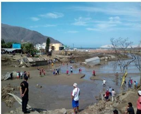
EL SANTA. La población del distrito de Coishco está aislada desde el miércoles pasado por lo que se intensifica la construcción de un paso provisional.
