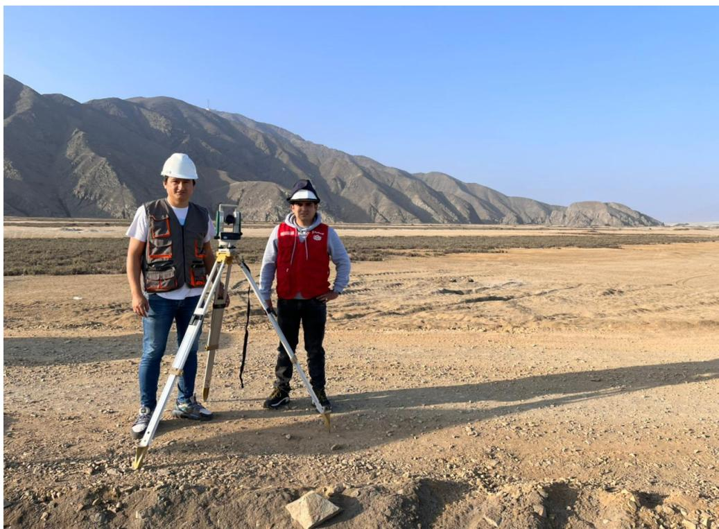
Imagen 11: El levantamiento topográfico se realizó con estación total, donde se pudo determinar que la superficie de la trocha en estudio es plana.
