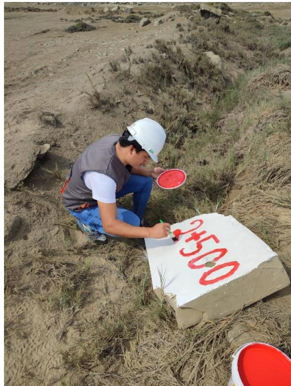
Imagen 05: En nuestra visita segunda visita, se colocaron las progresivas por cada 500m, según lo reglamento en el manual de Mantenimiento o Conservación Vial (MTC). CRISTIAN AUGUSTO HEREDIA SIFUENTES, investigador del presente proyecto.
