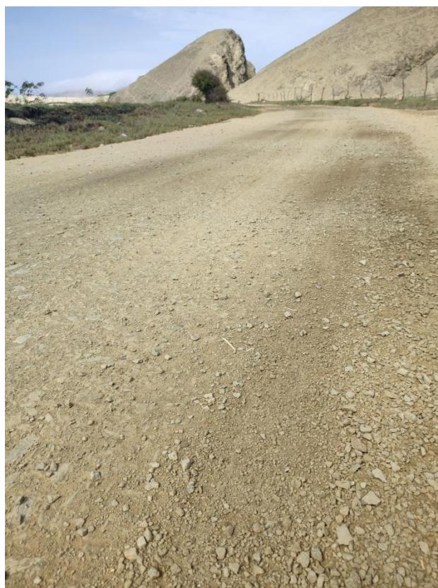
Imagen 04: se puede apreciar las deformaciones y encalaminado leve a lo largo de la trocha en estudio
