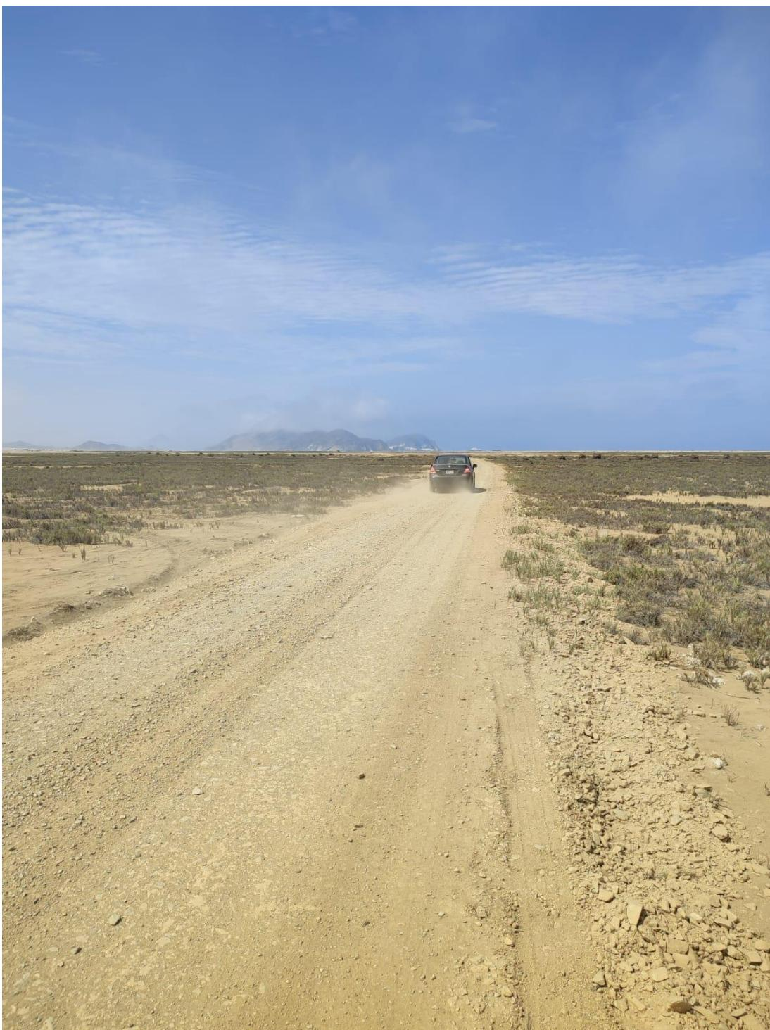
Imagen 02: Como se puede apreciar en la imagen, la trocha en estudio presenta bastante material suelto y levantamiento de polvo leve.
