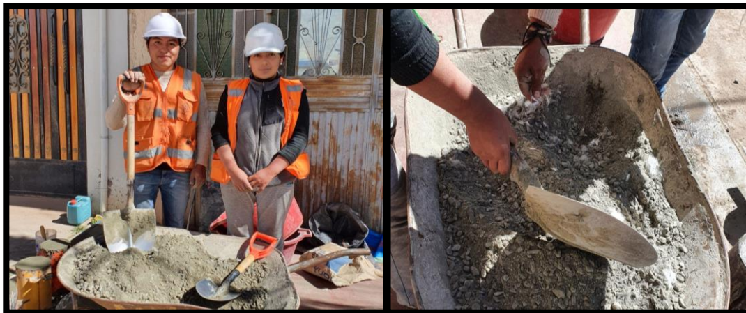
Ilustración n°5: inicio y preparado de mezcla de concreto convencional y concreto adicinado con fibras de polipropileno
