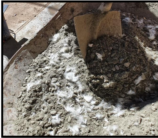
Figura 3. Concreto mezclado con fibras de polipropileno
