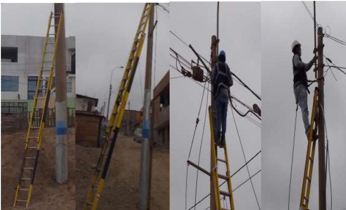
Figura 36. Implementación de escaleras para realizar las instalaciones
