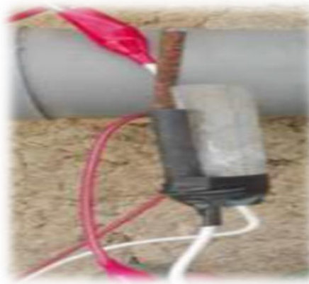
Figura N°5: Exterior del tubo con electrodos instalados
