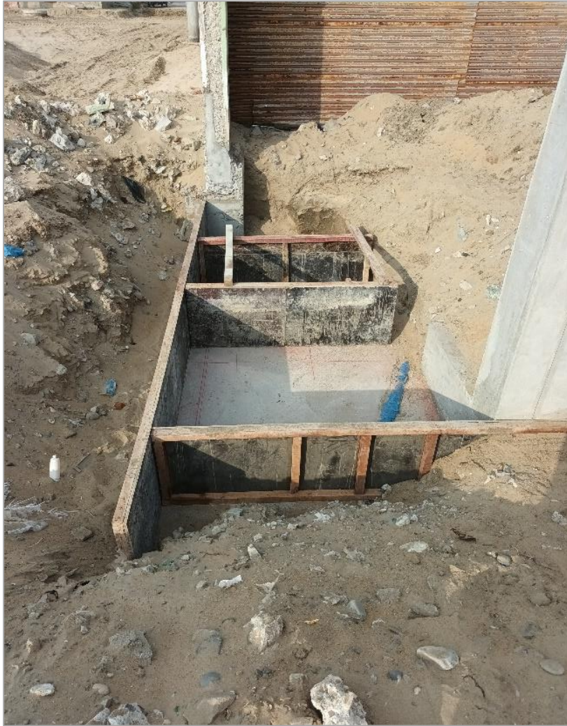
Figura 1. Trabajo de encofrado para un posterior vaciado de concreto
