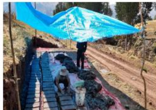
Figura 8: Elaboración de adobes y secado a la intemperie con cubierta temporal
