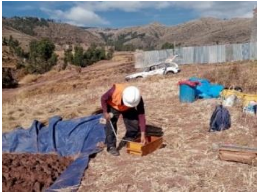
Figura 22. Molde de madera para adobe, corte y peso de la paja
