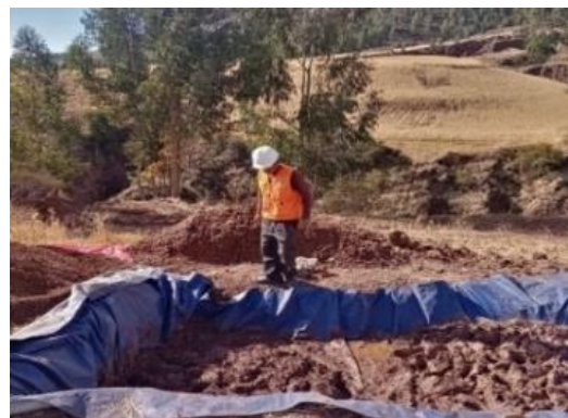
Figura 23. Incorporación de paja y mezcla para elaboración de adobe
