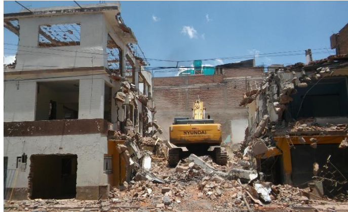
Figura 4. Demolición de vivienda en Juliaca
