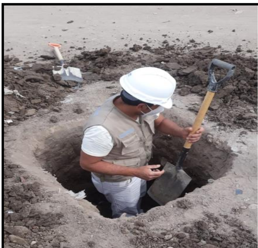
Foto 4. Procedimiento de excavación de calicata
