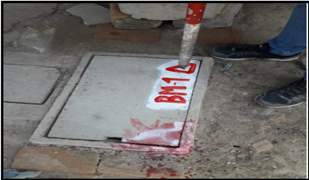
Foto 2. monumentación de puntos topográficos
