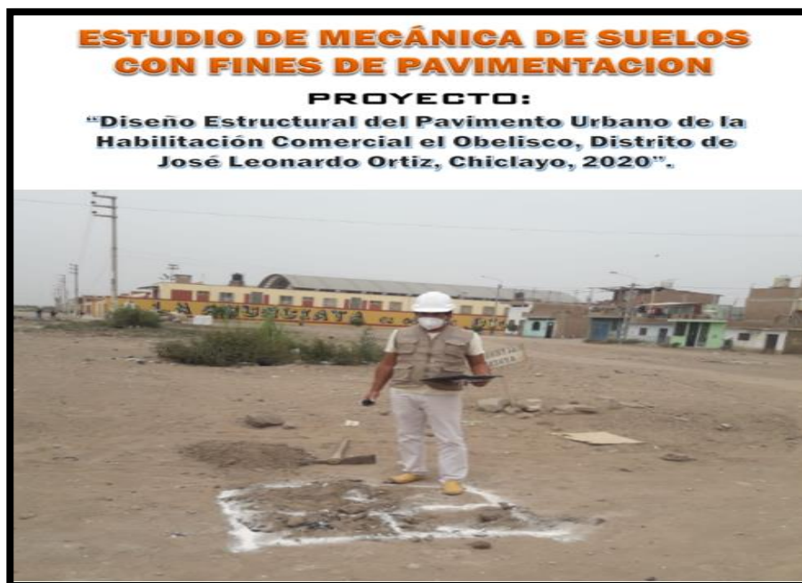
Foto 3. procedimiento de ubicación y trazado de dimensiones y geometría de calicata
