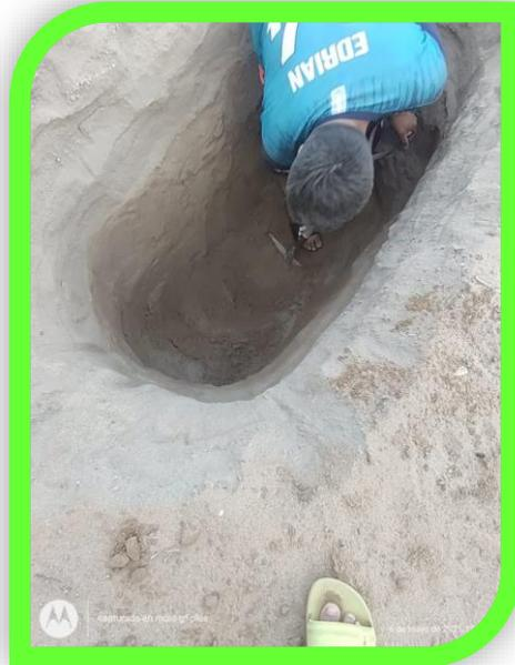
**Foto N°07:** Se visualiza a el colaborador en trabajos de excavación a un nivel de 1.50 m de la **C n°02**.
