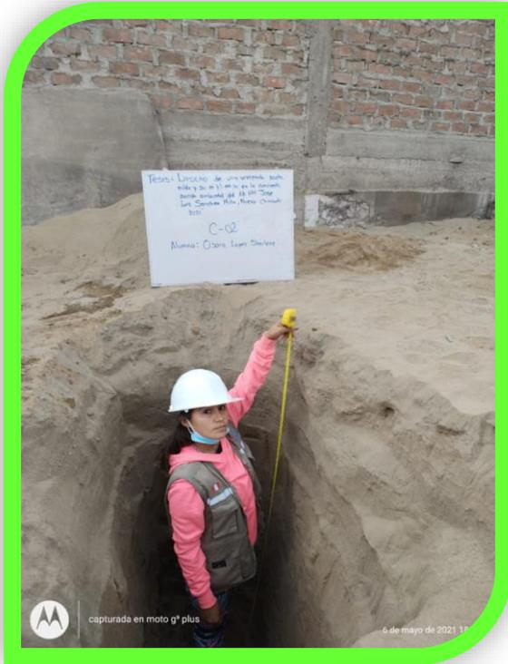
**Foto N°08:** Se visualiza a la alumna Osorio Lopez Sharlene en trabajos de la medición de profundidad de 1.80 m. de la **Cn°01**
