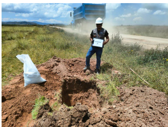
Figura 5. Apertura de la Calicata N° 1
