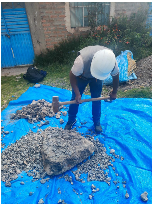
Figura 8. Trituración de residuos de pavimento rígido
