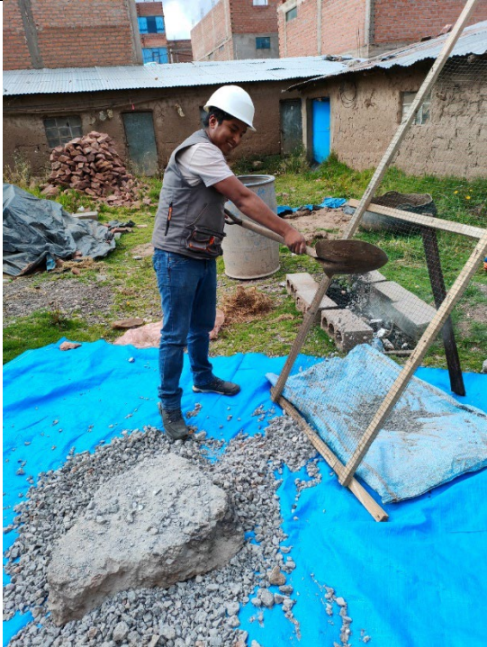
Figura 02. Triturado de pavimento rígido de concreto
