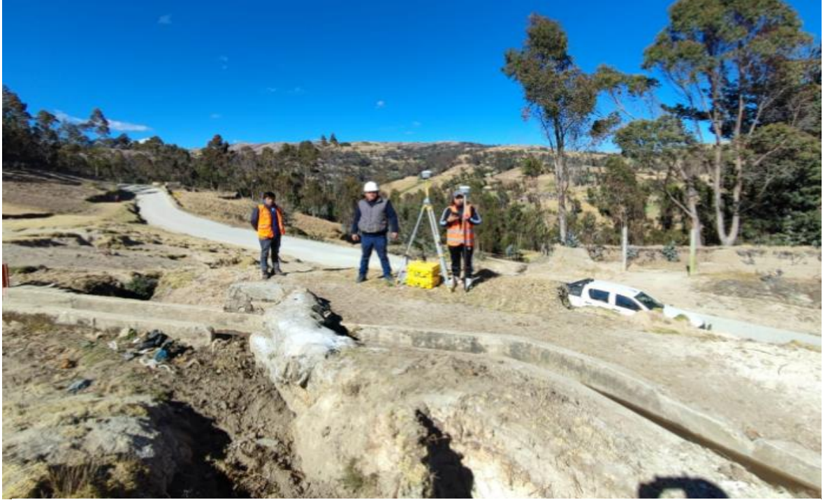
TRABAJO DE CAMPO PARA EL LEVANTAMIENTO TOPOGRAFICO.
