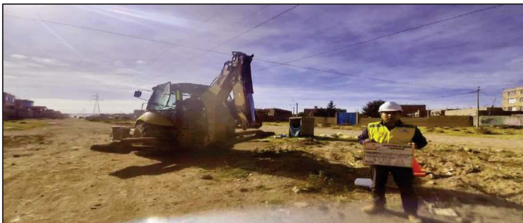
Figura 3. Fotografía de la vía no pavimentada, avenida Tintaya, Juliaca 2022.
