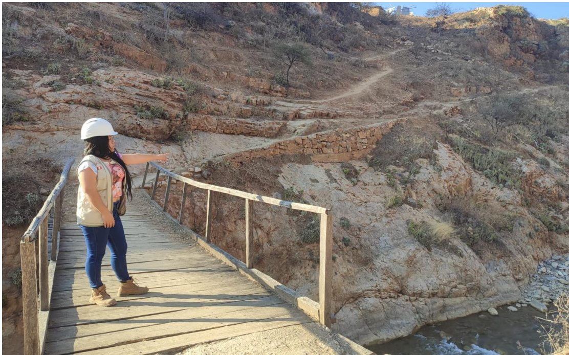
FOTO 06: Puente Peatonal de madera, el cual se diseñará como Puente Vehicular de la carretera que une los pueblos de San Jorge y Farrat.
