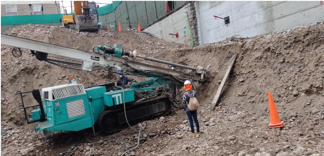
Figura 7: Proceso de inyección de anclaje
