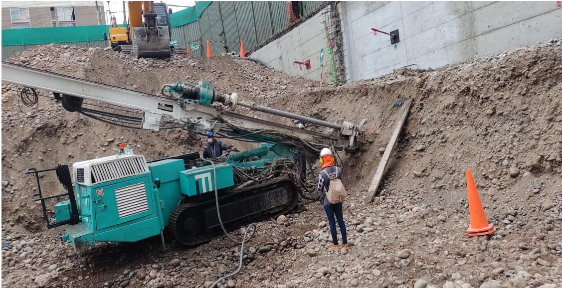
Figura 6: Proceso de perforación
