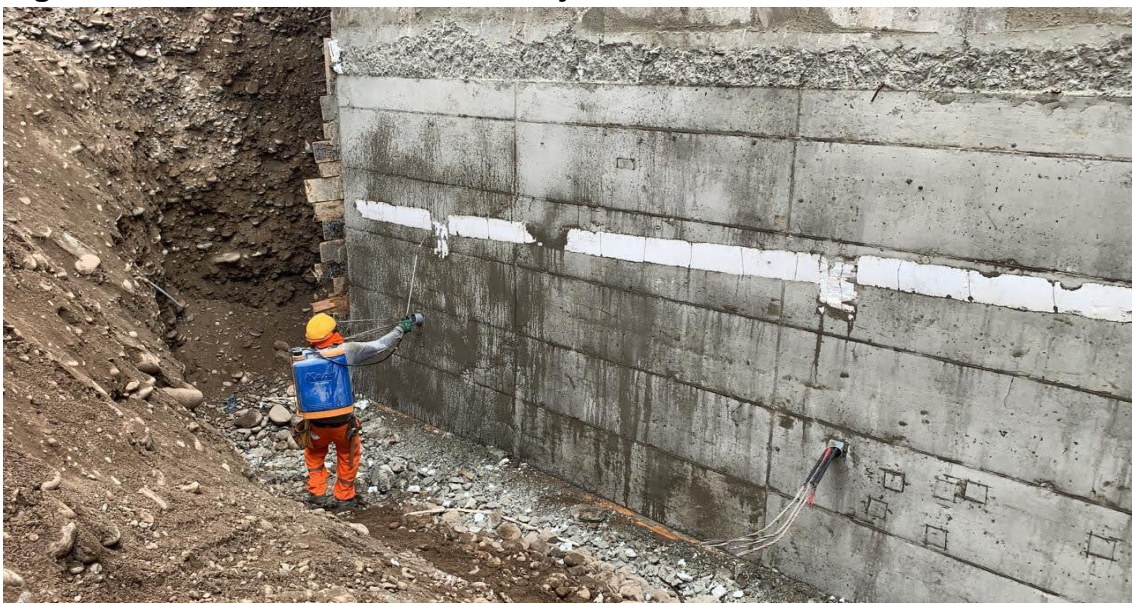
Figura 14: Curado del muro de anclaje
