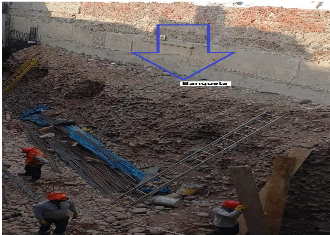
Figura 9: Identificación y perfilado de banqueta
