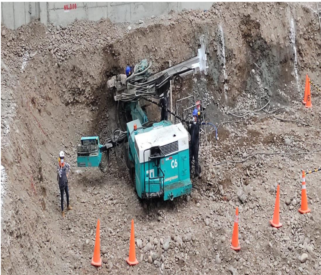
Figura 8: Procedimiento de inyección de lechada.
