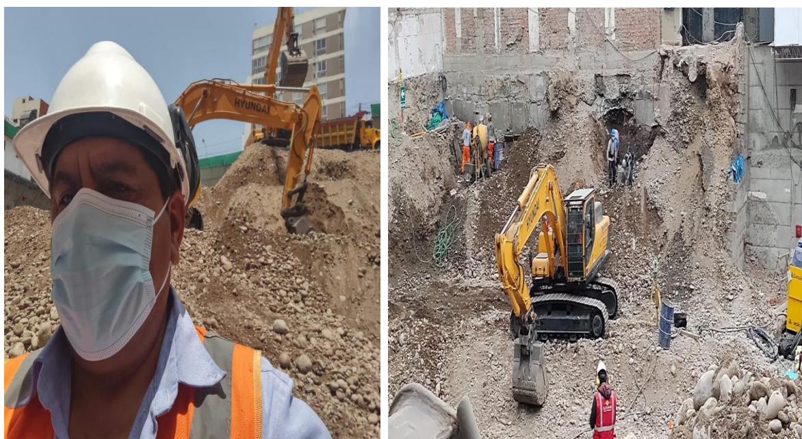
Figura N° 5: proceso de excavación masiva
