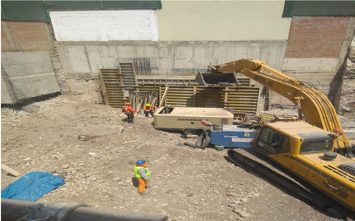
Figura 12: Colocación del encofrado
