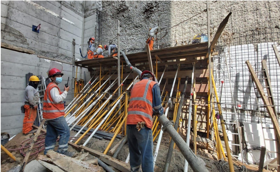
Figura 13: Colocación del encofrado
