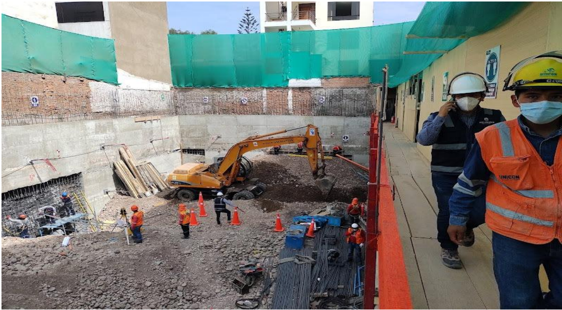
Figura 16: Muros terminados del primer anillo y empezando el segundo anillo.
