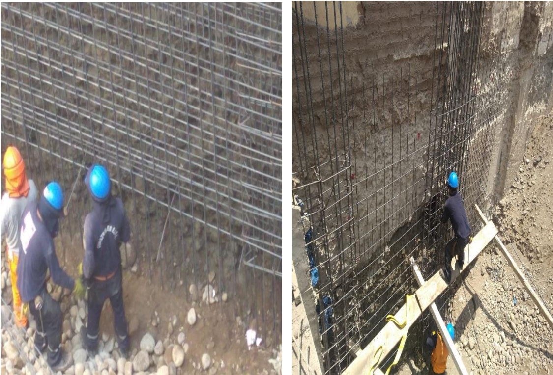
Figura 11: Colocación del acero
