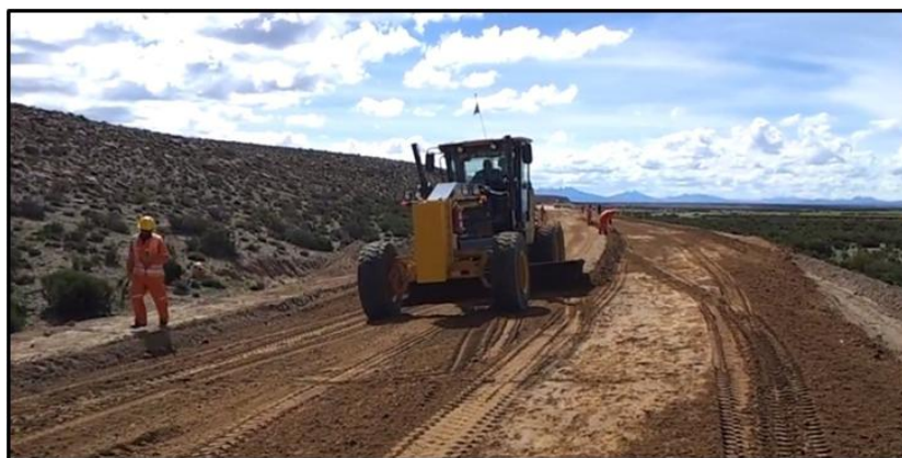
Figura 05. Subrasante de las vías en el distrito de Caracoto
