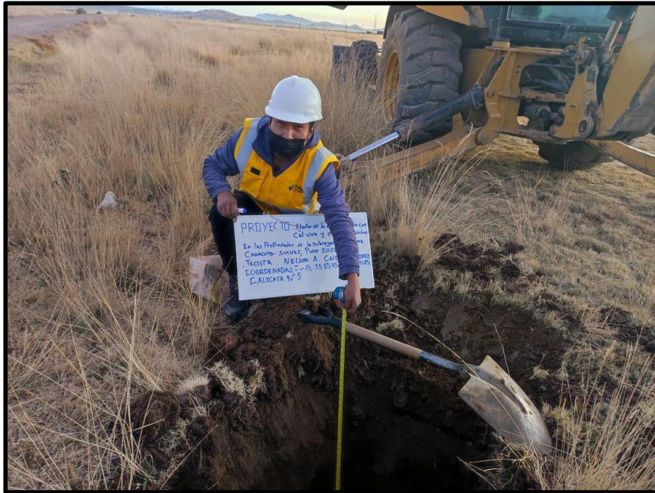
Fotografía 1. Exploración de calicatas en la vía Caracoto a Suches
