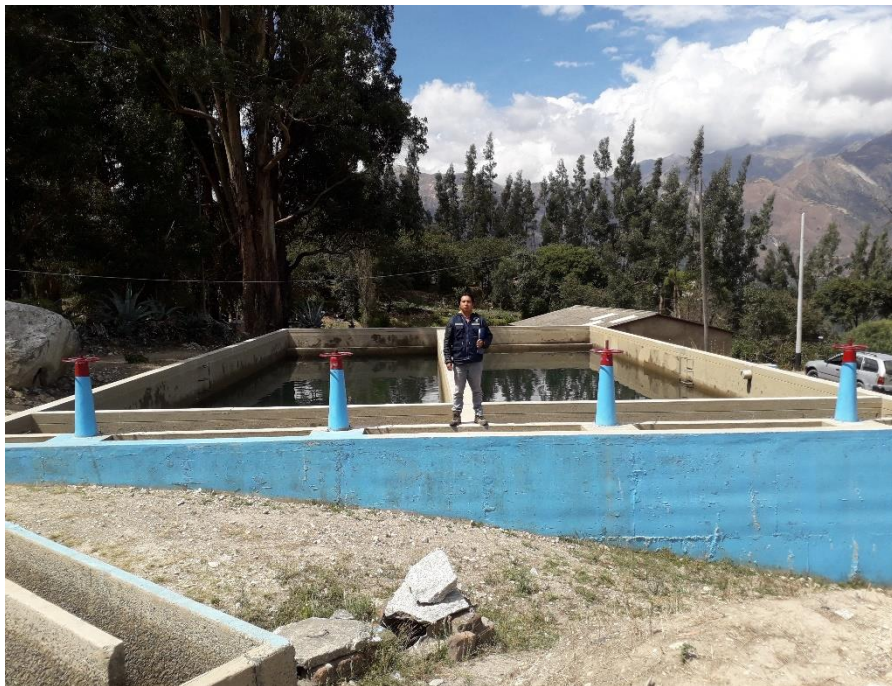
Vista Norte del Reservorio Cochaongo - PTAP
