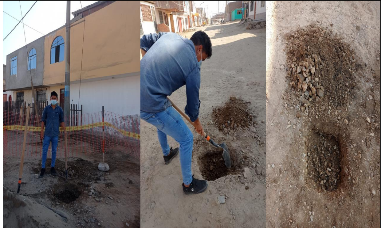
Reconocimiento de la zona para la realización de la primera calicata
