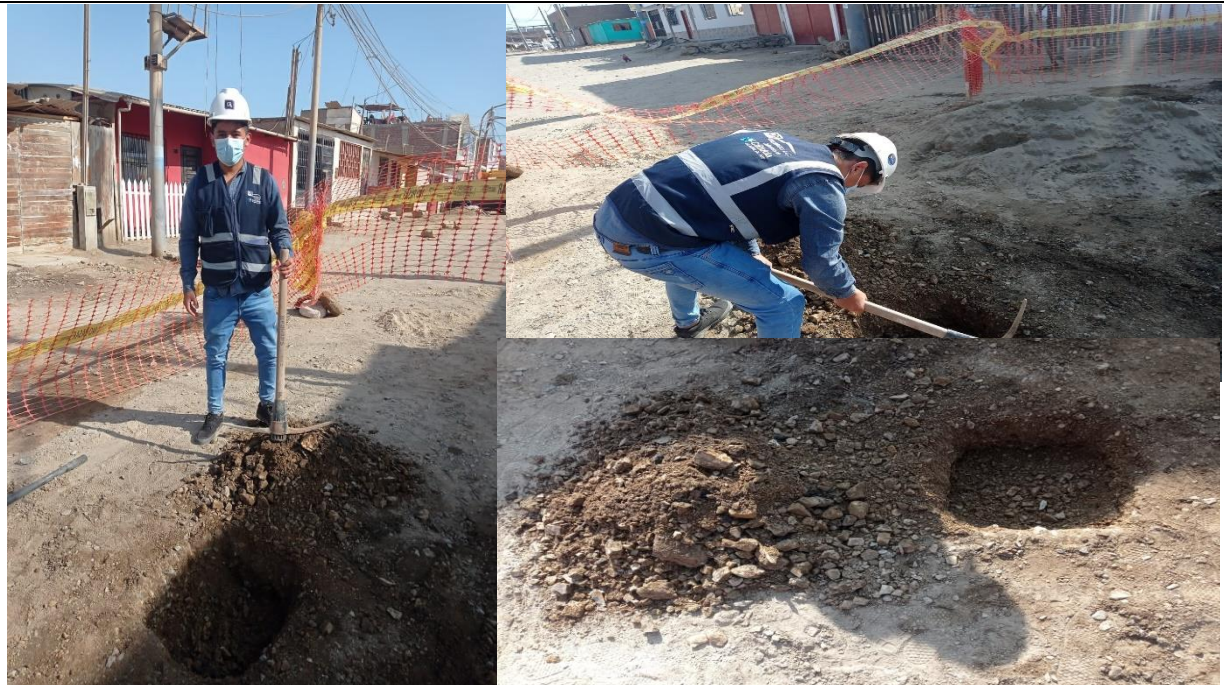
Reconocimiento de la zona para la realización de la tercera calicata
