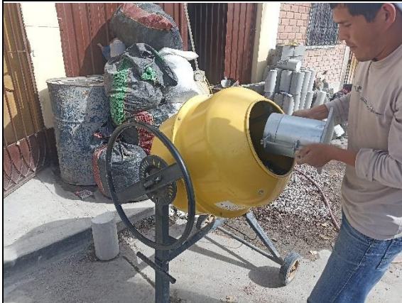
Foto N° 01: Preparacion de mezcla para el moldeo de ladrillo.
