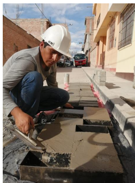
Figura 9. Pulido de los ladrillos en el molde
