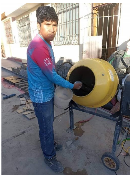
Figura 8. Sustitución del agregado fino por plástico reciclado cortado
