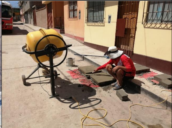
Foto N° 02: Elaboracion del patron de ladrillo macizo de concreto.
