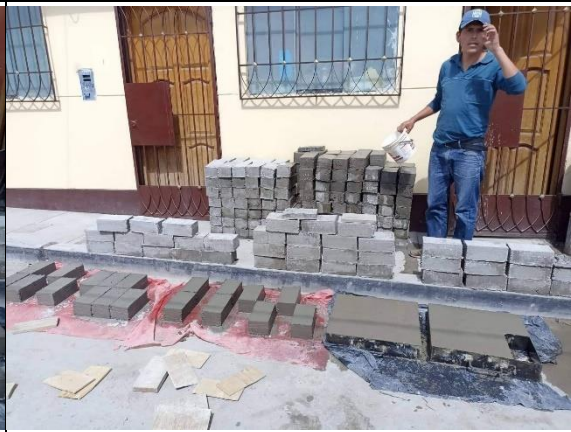
Foto N° 08: Elaboracion de ladrillo macizo de concreto.
