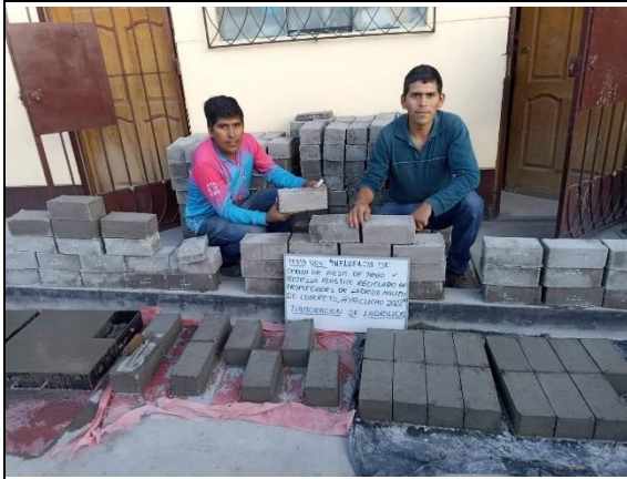
Foto N° 07: Elaboracion de ladrillo macizo de concreto.
