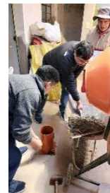
Fotografía 12: relleno de briqueteras.
