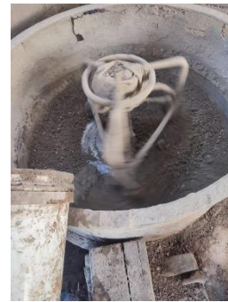
Fotografía 4: mezcla de agregados, cemento y agua.
