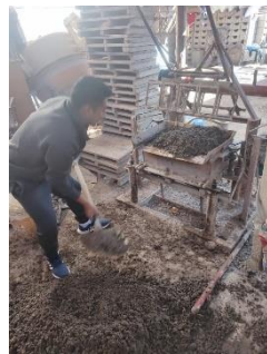
Fotografía 5: elaboración de bloques de concreto
