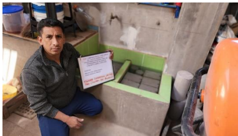
Fotografía 17: absorción bloques de concreto
