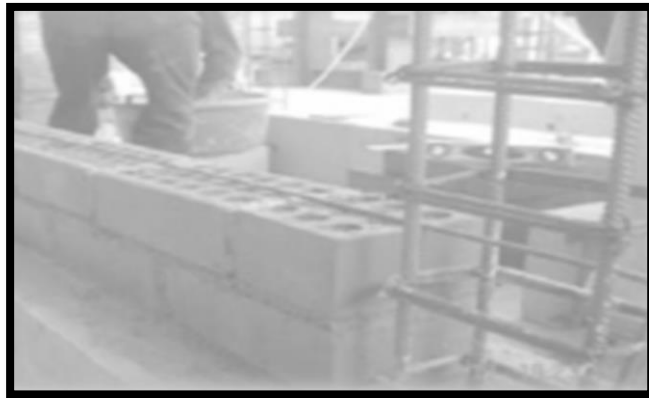
Figura N° 6: Descripción: Muro confinada a ras con chicotes
