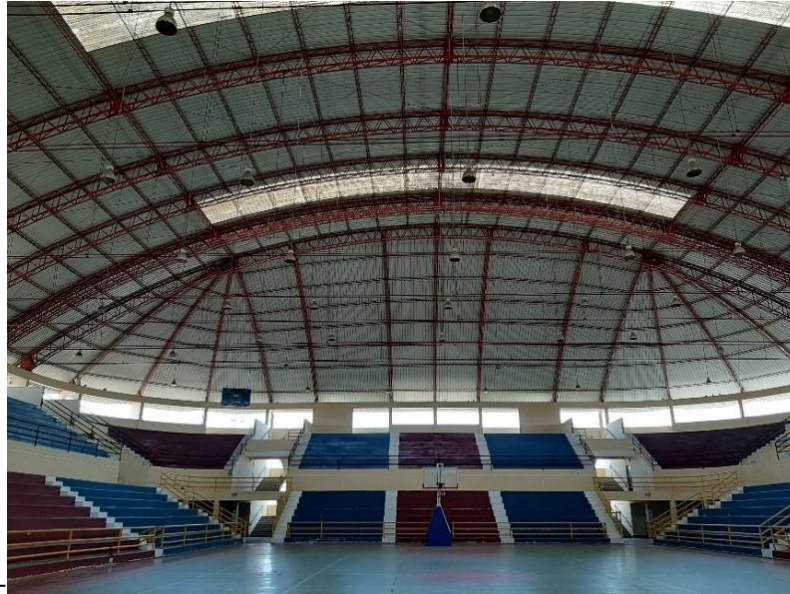
Figura 4: Interior del coliseo de cañete y las partes que constituyen el techo. Fuente propia.
