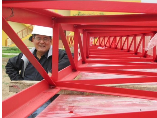
Figura 17: tipo de perfiles utilizados en el techo. Fuente:
