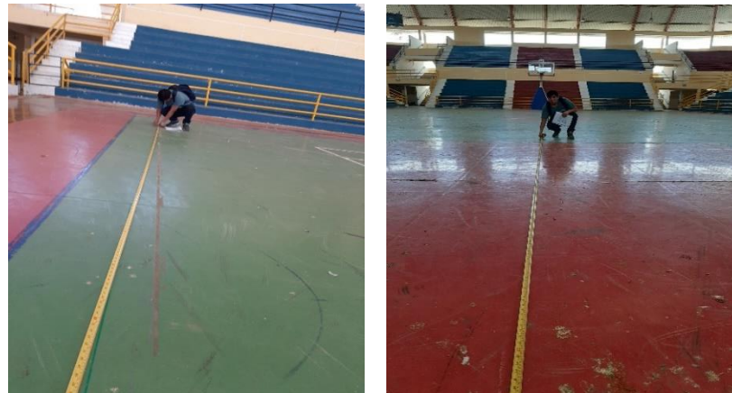
Figura 13: toma de datos de la distancia de los extremos de los ejes del arco de la viga. Fuente propia.
