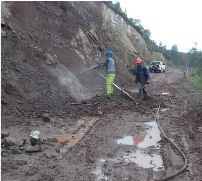
Foto 02: Explanación en roca fija.
