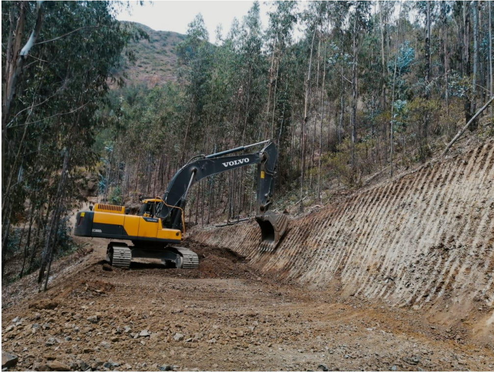
Foto 01: Explanación en material común.
