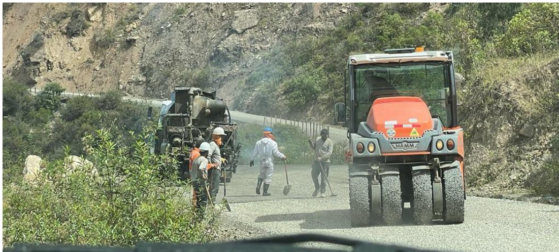
Foto 05: Imprimación asfáltica
