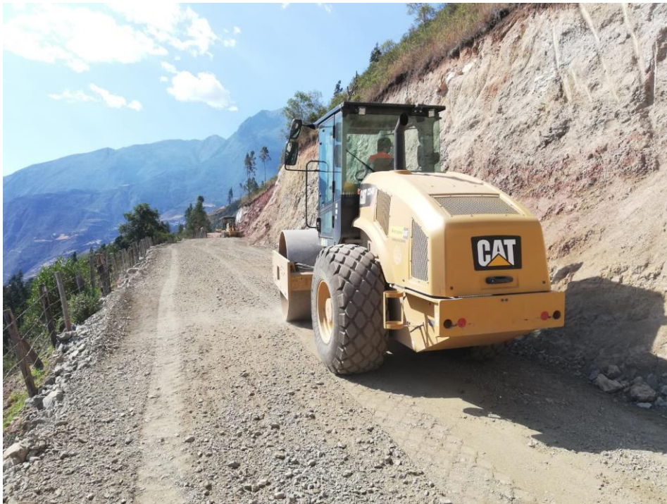
Foto 04: Compactado de afirmado.
