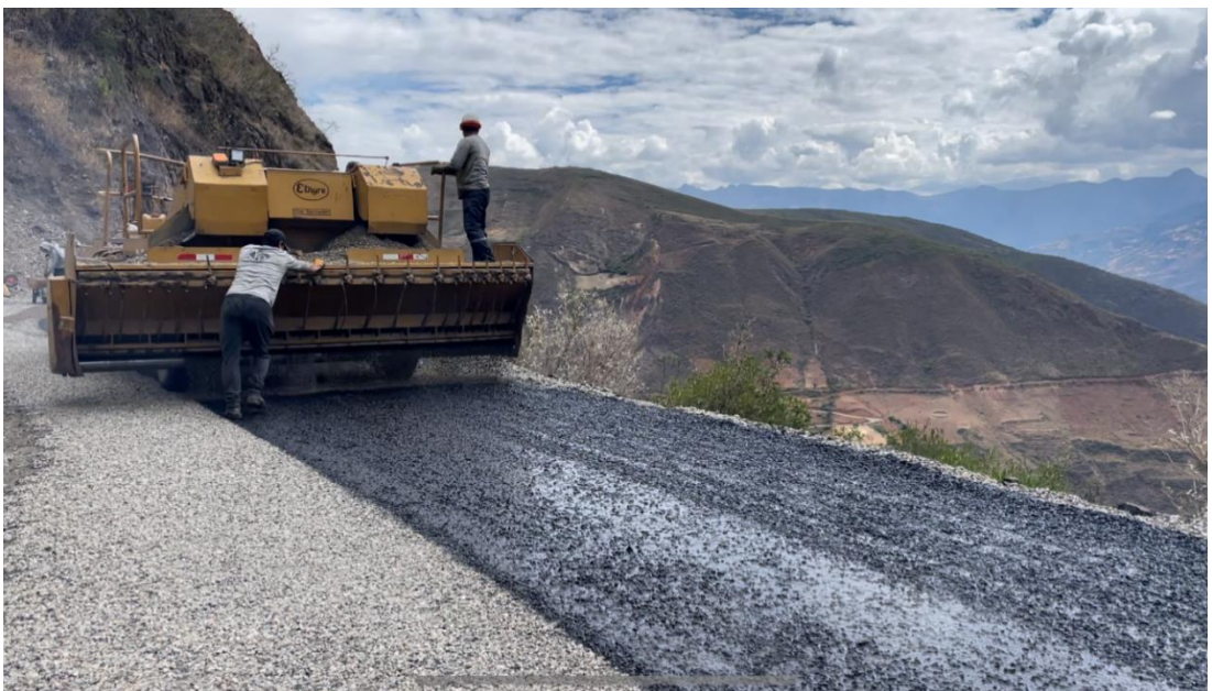
Foto 07: Aplicación de la segunda capa del tratamiento superficial bicapa.
