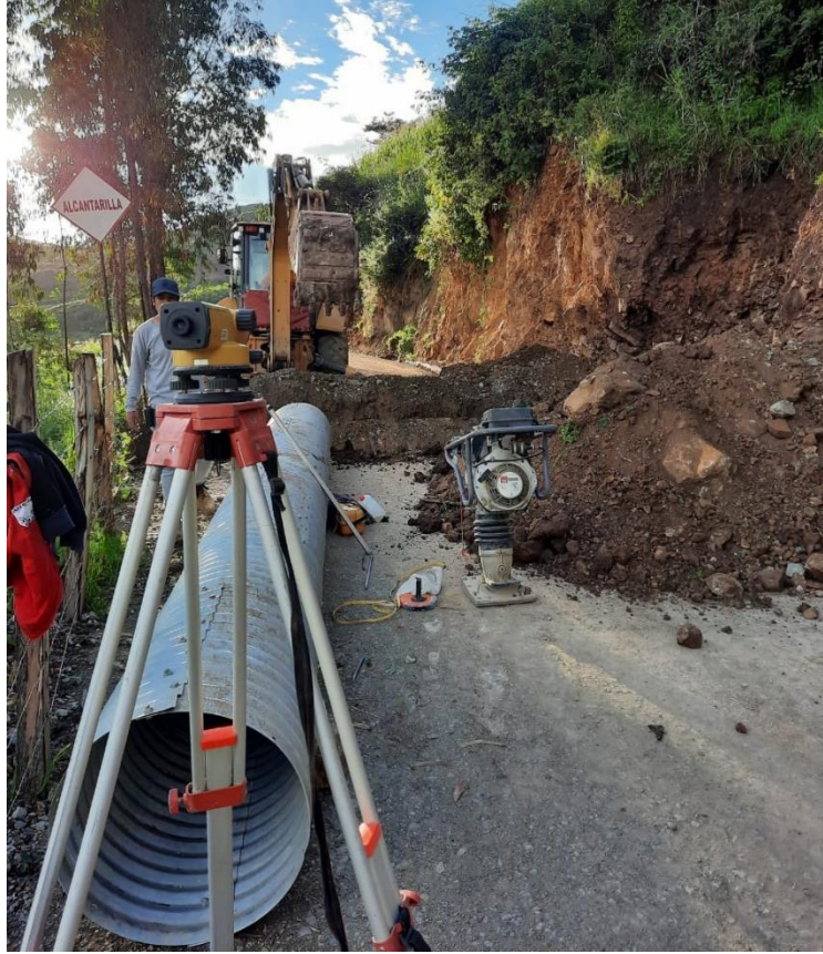
Foto 10: Instalación de alcantarilla TMC.
