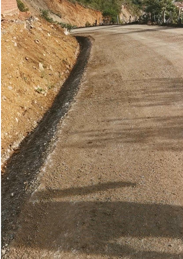
Foto 08: Conformación de cunetas de drenaje en todo el tramo de la plataforma.
