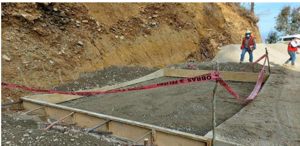
Foto 09: Armado de encofrado del Baden.
