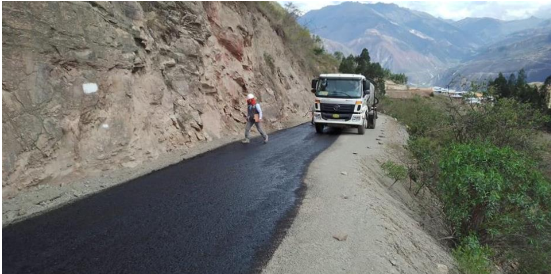
Foto 05: Imprimación asfáltica
