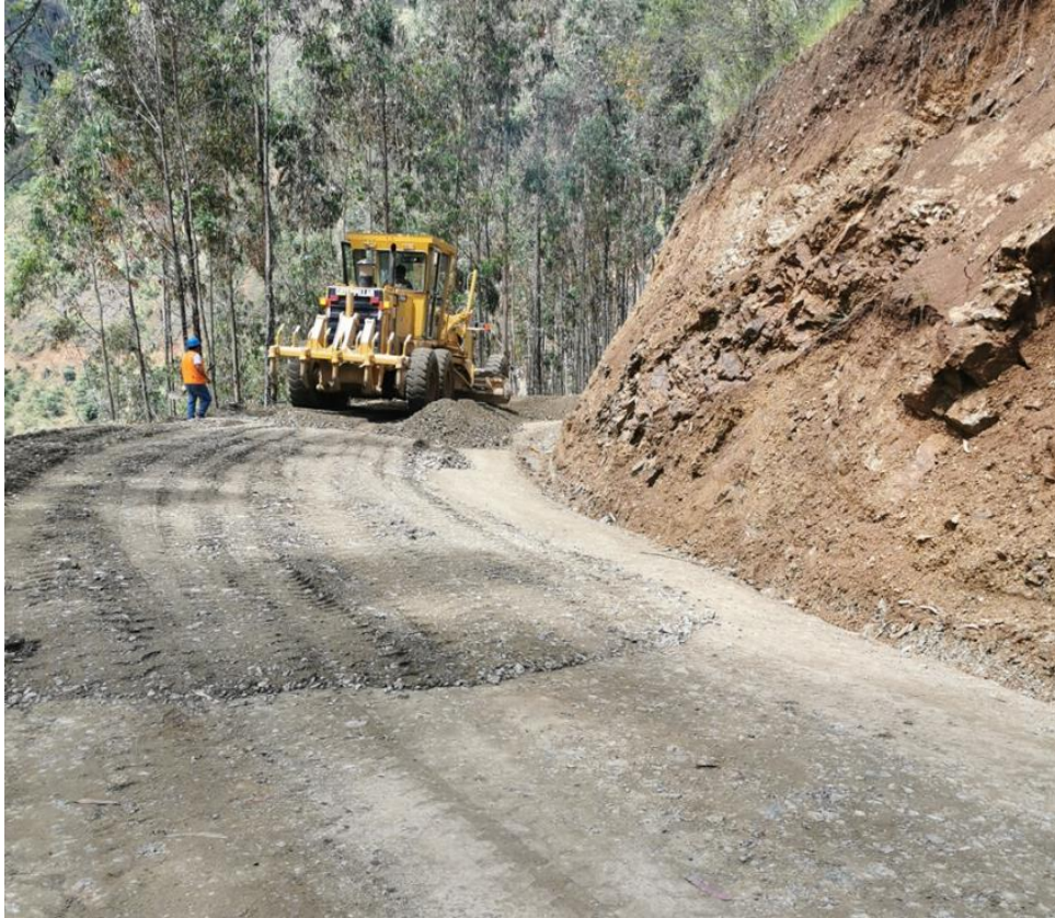
Foto 03: Tendido y nivelación de afirmado.
