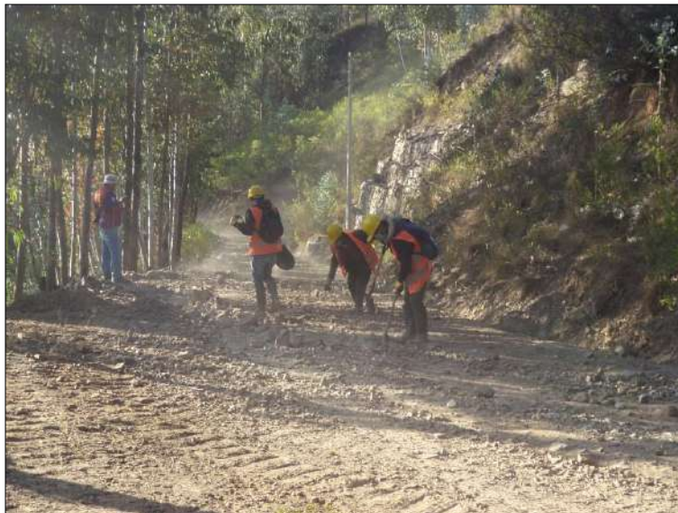
Foto N° 24: Vista de los trabajos de escarificado a nivel de sub rasante con personal obrero, progresiva 4+700. Sábado 10/10/2,020, coordenadas UTM: E=212,180.9501 N=9'052,900.1330.
