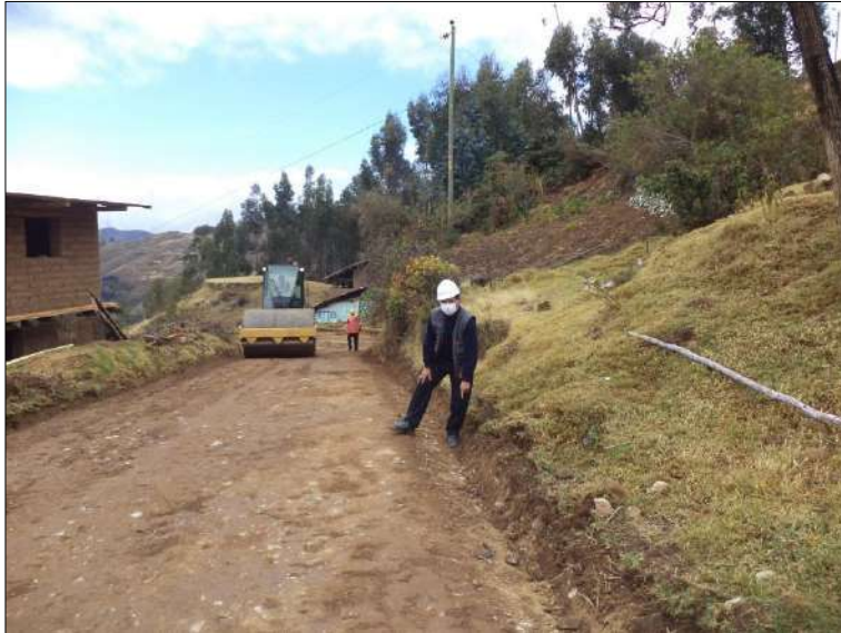
Foto N° 13: Vista de la superficie a nivel de sub rasante compactada, el Ingeniero Residente del Servicio señalando la reconformación de cuneta. Miércoles 07/03/10/2,020, coordenadas UTM: E=214,704.3721 N=9'053,417.2762.
