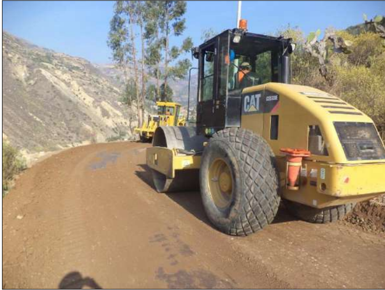
Foto N° 57: Vista del compactado con rodillo liso vibratorio a nivel de capa granular con material de cantera E = 0.15 m, progresiva 1+100. Sábado 21/11/2,020, coordenadas UTM: E=211,916.9807 N=9'052,413.6695.
