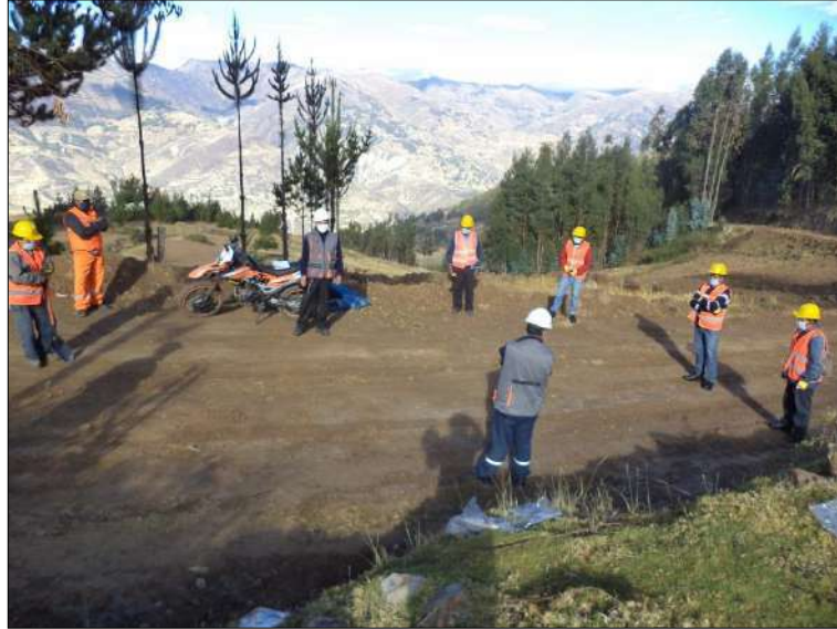
Foto N° 05: El Ingeniero Residente y maestro de obra, realizando la charla técnica, antes de empezar los trabajos de ejecución del servicio. Miércoles 07/10/2,020.
