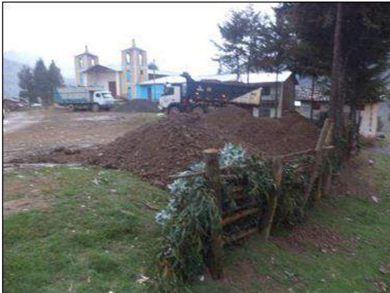
Foto N° 59: El Ing. Residente verificando la superficie compactada con material granular de cantera para afirmado E = 0.15 m, progresiva 0+840. Sábado 21/11/2,020, coordenadas UTM: E=211,740.3704 N=9'052,560.8478.
