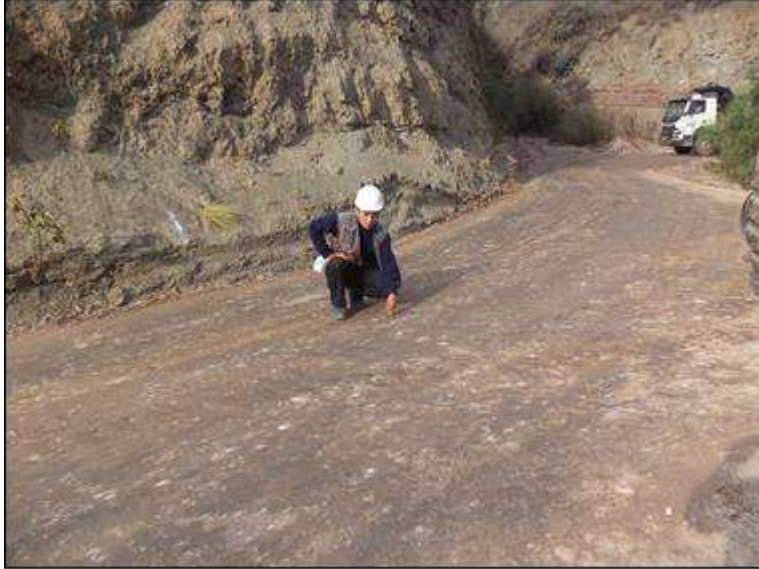
Foto N° 59: El Ing. Residente verificando la superficie compactada con material granular de cantera para afirmado E = 0.15 m, progresiva 0+840. Sábado 21/11/2,020, coordenadas UTM: E=211,740.3704 N=9'052,560.8478.
