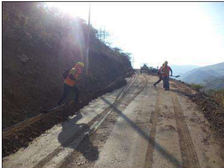
Foto N° 55: El Ingeniero Residente del Servicio, mostrando el esparcido de material granular de afirmado E = 0.15 m con motoniveladora, progresiva 5+150. Miércoles 18/11/2,020, coordenadas UTM: E=211,903.1380 N=9'053,161.3918.
