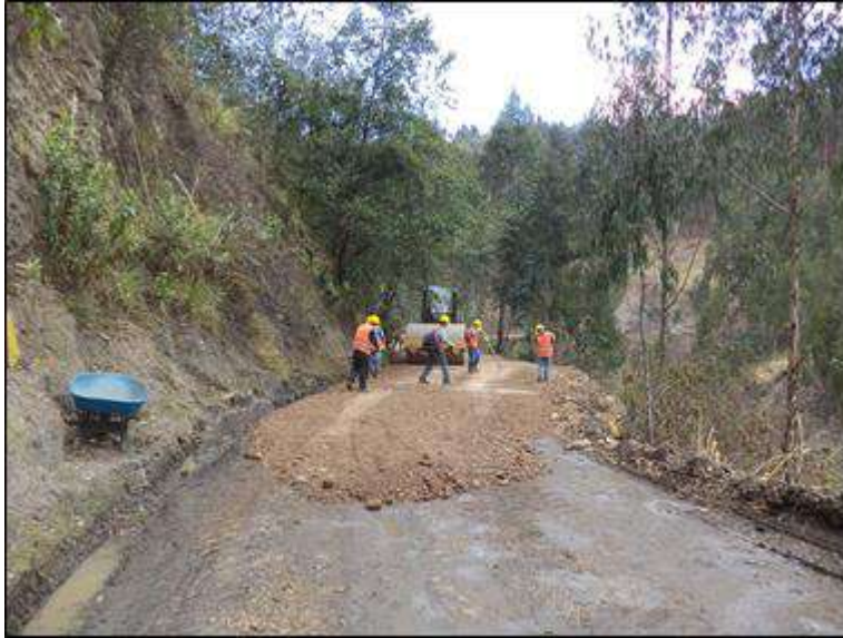
Foto N° 31: Conformación de material granular, capa nivelante E = 0.05 m, personal obrero en trabajos de esparcido del material de préstamo, progresiva 9+900. Martes 13/10/2,020, coordenadas UTM: E=213,724.5156 N=9'053,782.9291 .
