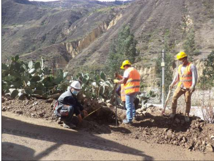
Foto N° 49: El Ingeniero Residente del Servicio, verificando las dimensiones de zapatas para señalización vial de acuerdo a plano del Plan de Trabajo, progresiva 0+010. Viernes 06/11/2,020, coordenadas UTM: E=211,222.1242 N=9'052,754.8061.
