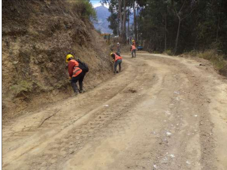
Foto N° 19: Vista de personal obrero en trabajos de reconfiguración de cunetas, progresiva 7+650. Viernes 09/10/2,020, coordenadas UTM: E=212,060.0362 N=9'053,682.8975.
