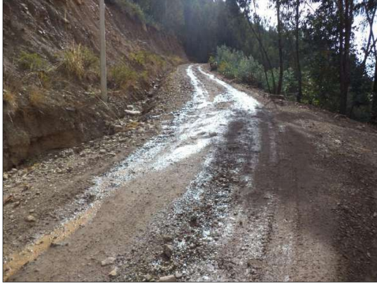
Foto N° 25: Vista de superficie de sub rasante regada anterior a los trabajos de perfilado, progresiva 4+350. Sábado 10/10/2,020, coordenadas UTM: E=211,874.1979 N=9'053,016.0985.
