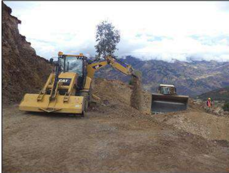
Foto N° 44: Vista de la extracción de material granular de cantera, progresiva 13+810. Sábado 31/10/2,020, coordenadas UTM: E=214,531.6501 N=9'053,208.2062 .
