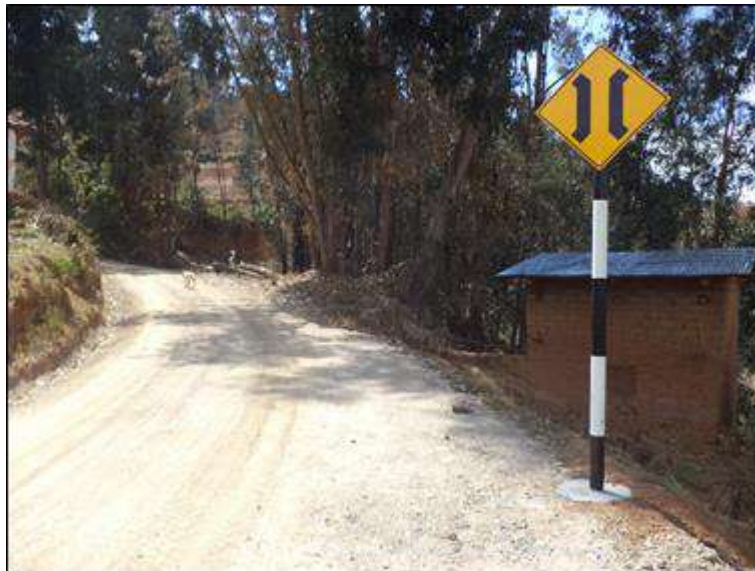
Foto N° 52: Vista de señal preventiva, código P – 49 puente angosto, progresiva 11+080 en ingreso a pontón. Sábado 07/11/2,020, coordenadas UTM: E=213,960.6734 N=9'052,894.8215.
