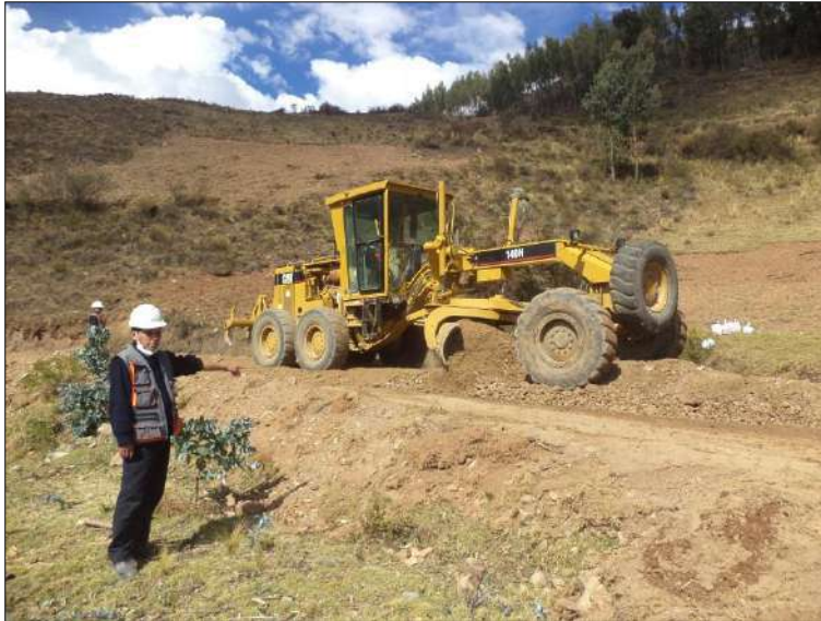
Foto N° 43: El Ing. Residente, mostrando el esparcido de material granular de afirmado E = 0.15 m con motoniveladora, progresiva 11+200. Lunes 26/10/2,020, coordenadas UTM: E=213,984.6854 N=9'052,795.3707 .
