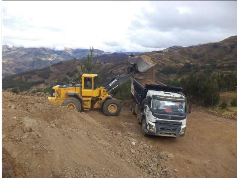
Foto N° 45: Vista del carguío de material granular de cantera, progresiva 13+810. Sábado 31/10/2,020, coordenadas UTM: E=214,531.6501 N=9'053,208.2062.
