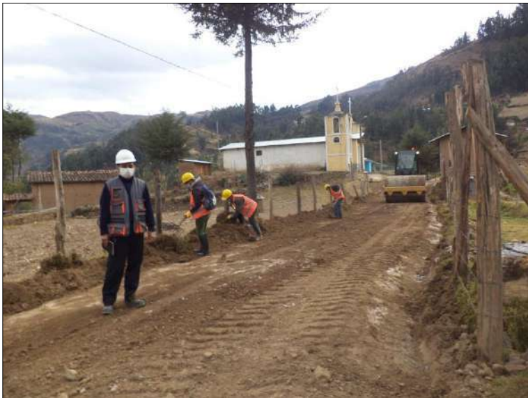
Foto N° 22: El Ingeniero Residente, verificando los trabajos de compactado de la sub rasante con la maquinaria rodillo liso vibratorio y reconfiguración de cunetas con personal obrero. Sábado 10/10/2,020, coordenadas UTM: E=211,946.8977 N=9'053,895.4951.
