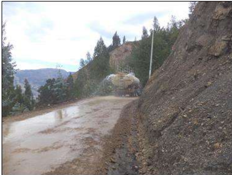
Foto N° 32: Camión cisterna realizando el regado de capa nivelante, progresiva 9+600. Martes 13/10/2,020, coordenadas UTM: E=213,505.2309 N=9'053,613.9099 .
