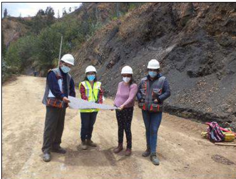
Foto N° 33: Visita técnica, de izquierda a derecha: Ing. Residente, Ing. del I.V.P, Ing. Inspector e Ing. Asistente técnico, progresiva 9+600. Martes 13/10/2,020, coordenadas UTM: E=213,505.2309 N=9'053,613.9099.
