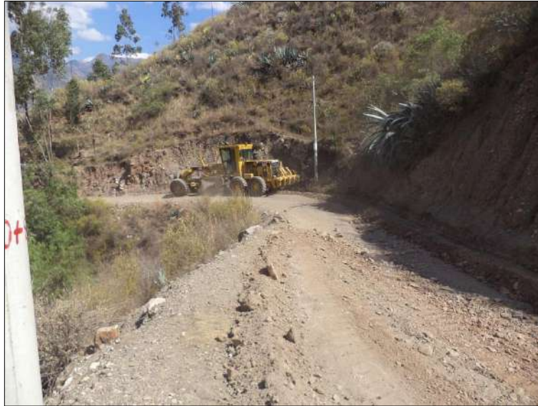
Foto N° 27: Trabajos de reconfiguración de cuneta a nivel de sub rasante con motoniveladora, progresiva 0+800. Lunes 12/10/2,020, coordenadas UTM: E=211,703.8890 N=9'052,566.7482.
