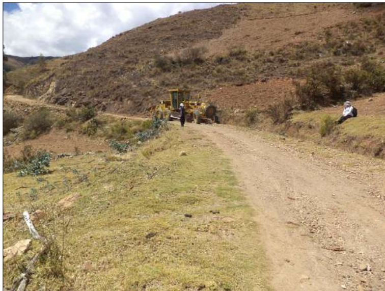
Foto N° 16: Perfilado y reconfiguración de cunetas con motoniveladora a nivel de sub rasante. Jueves 08/10/2,020, coordenadas UTM: E=214,203.4096 N=9'053,042.4889.
