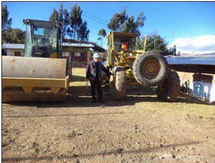
Foto N° 02: El Ingeniero Residente del Servicio con la maquinaria puesta en obra para el inicio del servicio de mantenimiento periódico. Miércoles 07/10/2,020, coordenadas UTM: E=214,723.7592 N=9'053,400.1812.
