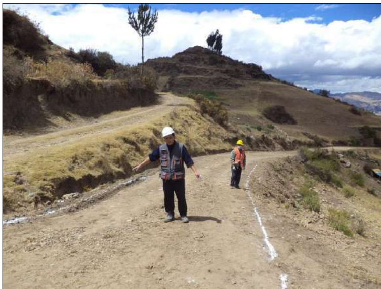
Foto N° 9: El Ingeniero Residente del Servicio verificando los trabajos de trazo y replanteo de la calzada, progresiva 13+930.24. Miércoles 07/10/2,020, coordenadas UTM: E=214,617.2184 N=9'053,283.5004.
