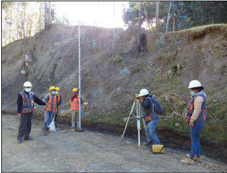
Foto N° 39: El Ing. Residente verificando los trabajos de emplantillado para la colocación del material granular de afirmado E = 0.15 m. Sabado 17/10/2,020, coordenadas UTM: E=213,817.2257 N=9'053,768.9707 .
