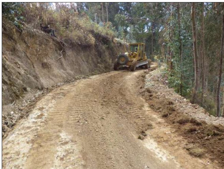
Foto N° 14: Trabajo de perfilado de reconformación de cuneta con motoniveladora a nivel de sub rasante. Jueves 08/10/2,020, coordenadas UTM: E=214,294.0529 N=9'053,379.7273.
