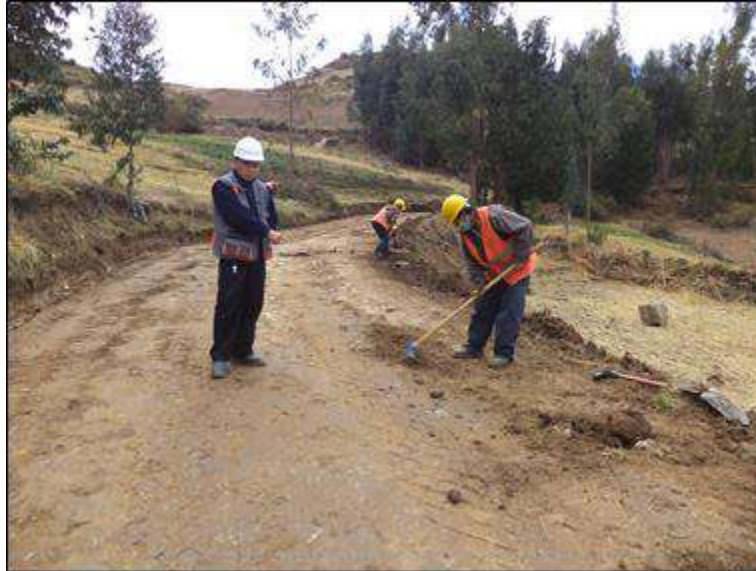
Foto N° 15: El Ingeniero Residente del Servicio verificando los trabajos de eliminación de champa en la superficie a nivel de sub rasante. Jueves 08/10/2,020, coordenadas UTM: E=214,436.8050 N=9'053,312.5209.
