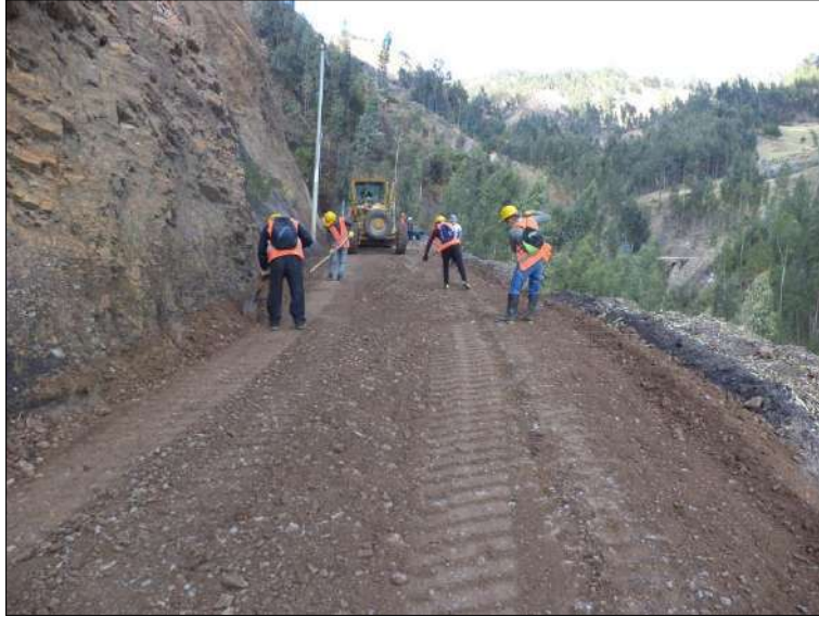
Foto N° 35: Vista del personal obrero en labores de esparcido de material de préstamo para capa nivelante E = 0.05 m, progresiva 9+510. Martes 13/10/2,020, coordenadas UTM: E=213,421.5779 N=9'053,582.0481.
