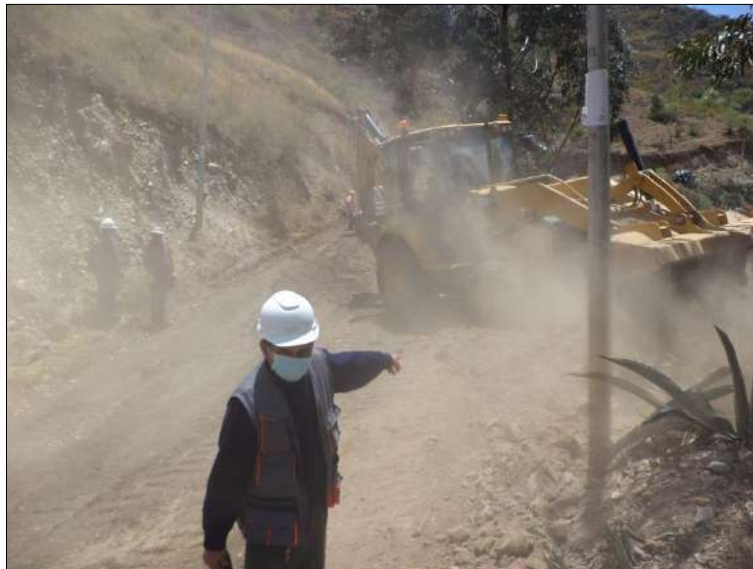
Foto N° 30: El ingeniero residente del servicio, verificando los trabajos de limpieza de derrumbes y huaycos con retroexcavadora, progresiva 0+370. Lunes 12/10/2,020, coordenadas UTM: E=211,368.1757 N=9'052,771.8348.
