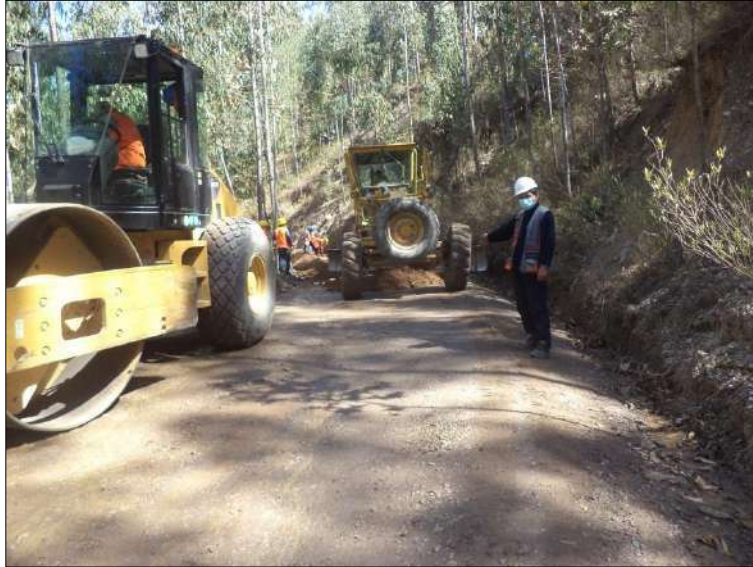
Foto N° 55: El Ingeniero Residente del Servicio, mostrando el esparcido de material granular de afirmado E = 0.15 m con motoniveladora, progresiva 5+150. Miércoles 18/11/2,020, coordenadas UTM: E=211,903.1380 N=9'053,161.3918.
