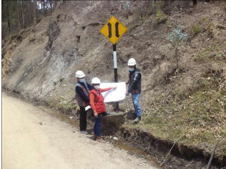
Foto N° 47: La Ing. Inspector y el Ing. Residente del Servicio verificando la colocación de señal preventiva, de código P – 49 puente angosto, a la salida del pontón, progresiva 10+000. Miércoles 04/11/2,020.
