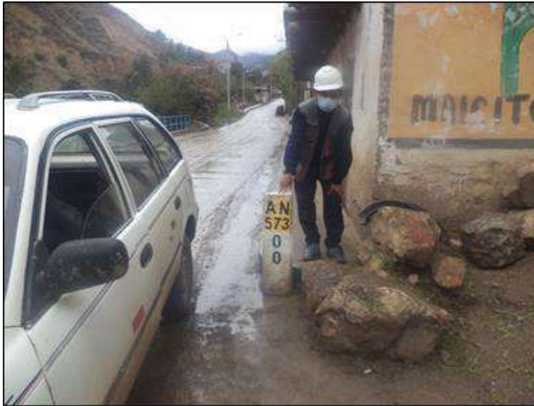
Foto N° 63: El Ingeniero Residente del Servicio, mostrando la colocación del hito kilométrico AN 573 - 0 km. Lunes 23/11/2,020.
