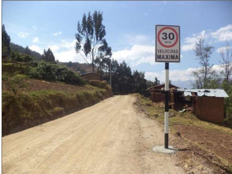
Foto N° 51: Vista de señal reglamentaria, de código R – 30 velocidad máxima, progresiva 10+700. Sábado 07/11/2,020, coordenadas UTM: E=213,844.8402 N=9'053,249.3323.
