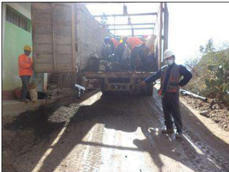
Foto N° 48: El Ingeniero Residente del Servicio, mostrando la puesta del material de agregados para la producción de concreto a ser usado en la cimentación de las señales viales, progresiva 0+010. Viernes 06/11/2,020, coordenadas UTM: E=211,222.1242 N=9'052,754.8061.
