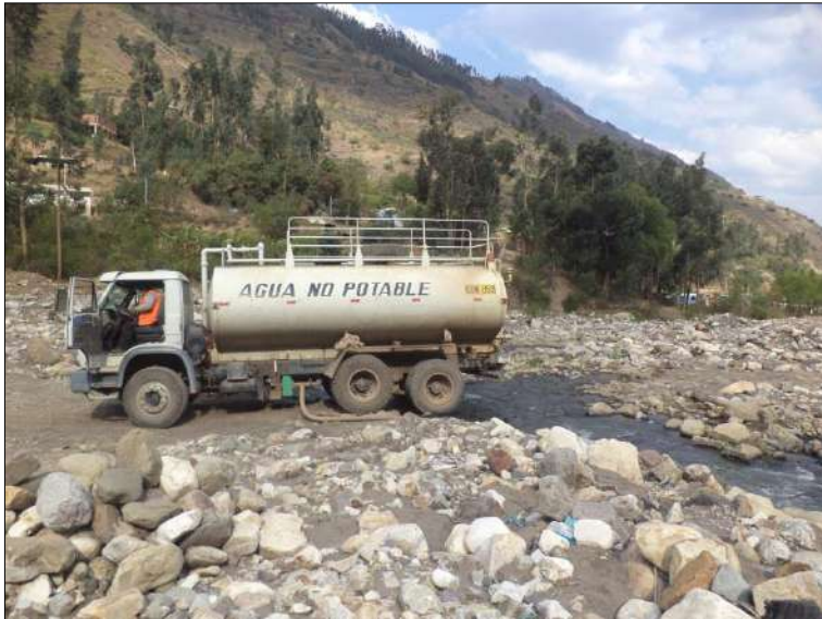
Foto N° 58: Camión cisterna de la contrata captando agua no potable del rio Sihuas, el cual presenta mayor caudal y acceso a captación que la fuente propuesta en el Plan de Trabajo, que presenta un aforo menor a \frac{1}{2} lt/s debido a la sequía en la zona. Sábado 21/11/2,020.
