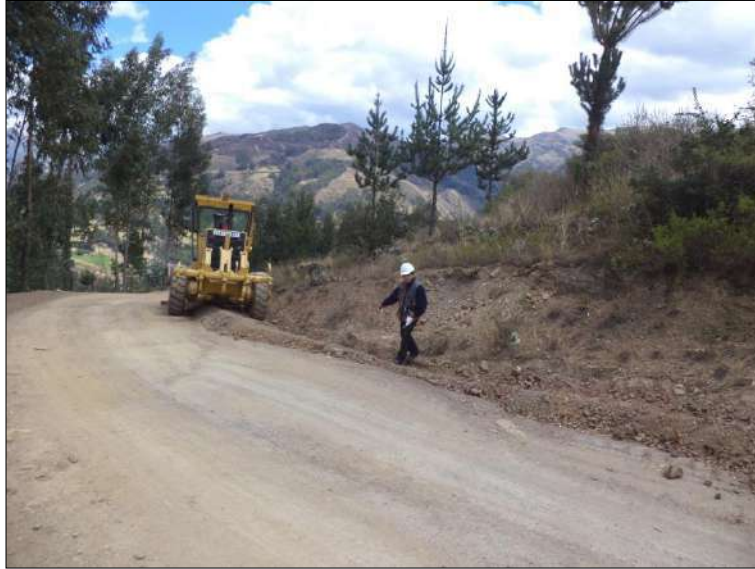
Foto N° 17: El Ingeniero Residente, verificando los trabajos de reconfiguración de cuneta a nivel de sub rasante con motoniveladora, progresiva 8+000. Viernes 09/10/2,020, coordenadas UTM: E=212,222.6376 N=9'053,445.4303.
