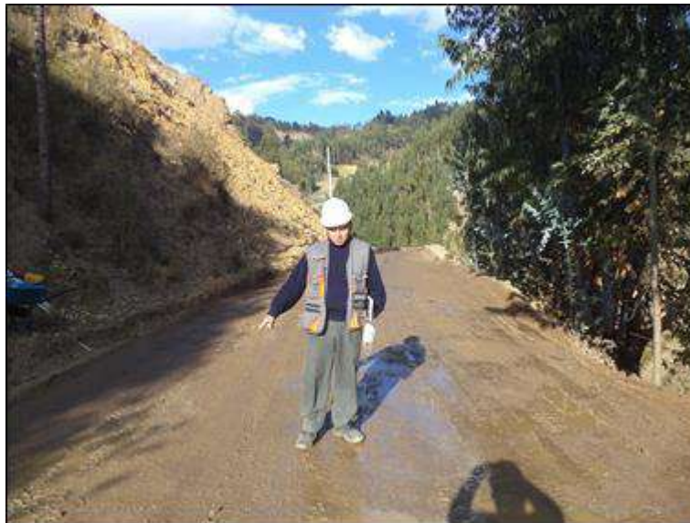
Foto N° 36: El Ing. Residente verificando la superficie compactada con material de préstamo en capa nivelante, progresiva 9+600. Martes 13/10/2,020, coordenadas UTM: E=213,505.2309 N=9'053,613.9099.
