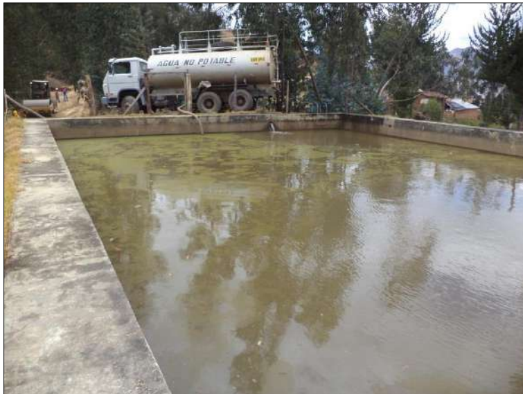
Foto N° 18: Camión cisterna recargando agua no potable para regado de superficie a nivel de sub rasante, progresiva 7+730. Viernes 09/10/2,020, coordenadas UTM: E=212,118.9628 N=9'053,628.8022.
