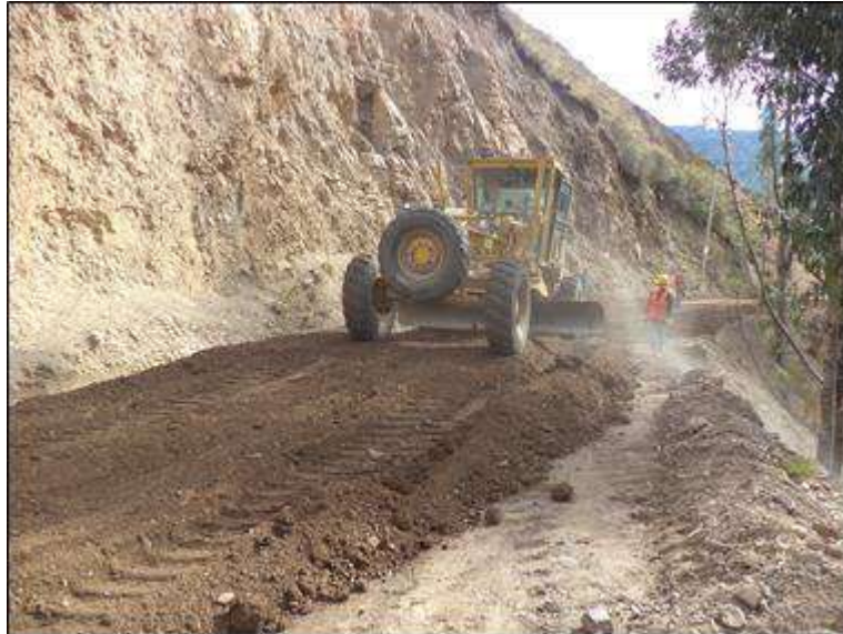
Foto N° 38: Conformación de material granular de cantera para afirmado E = 0.15 m, con motoniveladora, progresiva 9+400. Miércoles 14/10/2,020, coordenadas UTM: E=213,314.6203 N=9°053,604.9720.
