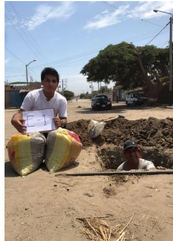
Foto N° 10: Excavación de calicata 01, 8^{\circ} 58' 10.688'' S 78^{\circ} 34' 38.550'' W
