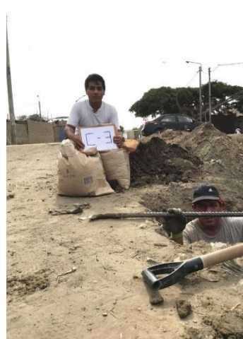
Foto N° 12: Excavación de calicata 03, 8^{\circ} 58' 12.977'' S 78^{\circ} 34' 34.303'' W
