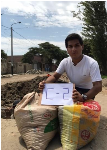
Foto N° 11: Excavación de calicata 02, 8^{\circ} 58' 11.832'' S 78^{\circ} 34' 36.659'' W
