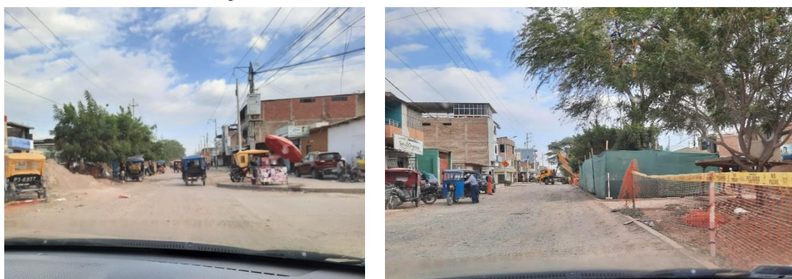
Figura 2: Situación actual de la Av. Buenos Aires
