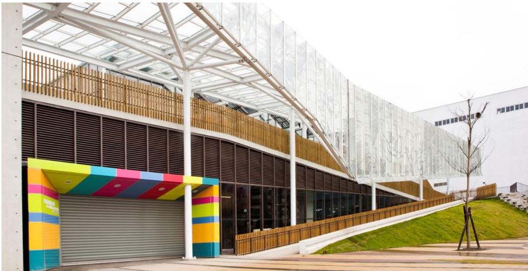
Figura 18: Fachada principal – Mercado de Flores
