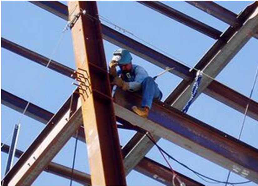
Figura 3. Columnas de la estructura metálica de un edificio
