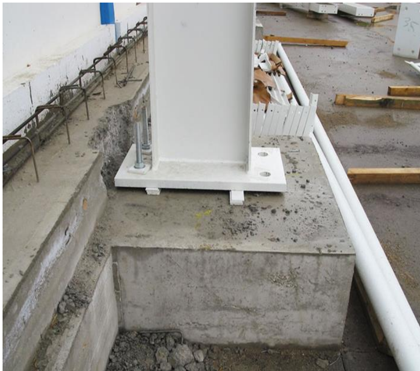
Figura 2. Cimentación de losa para la estructura metálica de un edificio
