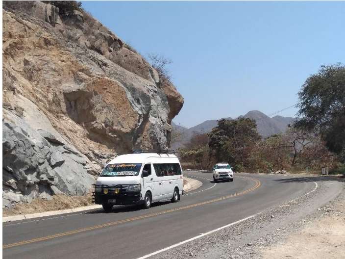
Figura 26: Talud de estudio ubicado en una curva.
