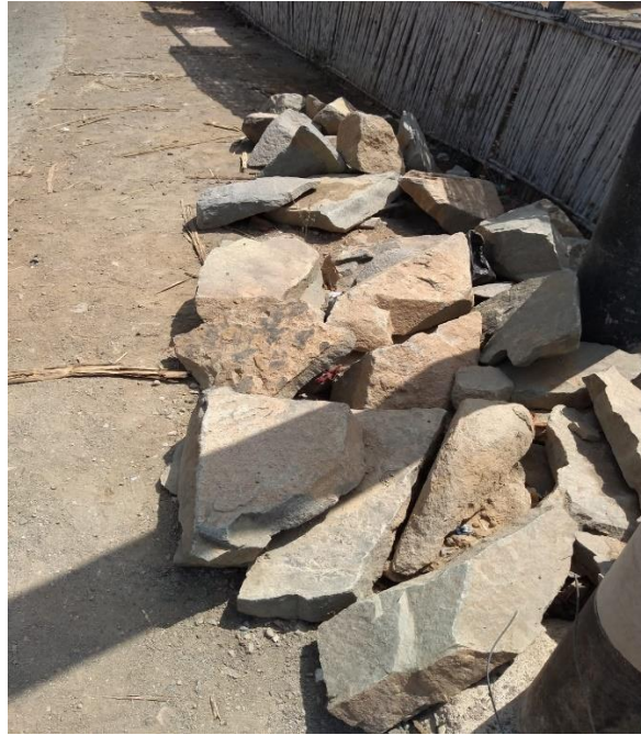
Figura 14: Acumulación de materiales sueltos del talud. Elaboración propia.
