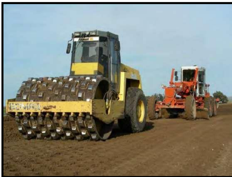
Figura 1. Consolidación por compactación mediante maquinaria pesada “pata de cabra”.
