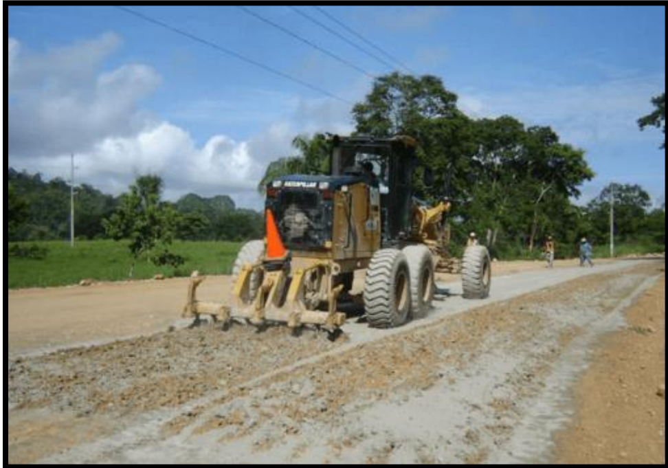
Figura 2. Estabilización química de suelos.
