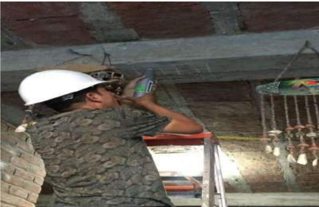
Figura N°2: Ensayo de esclerometría en viga
