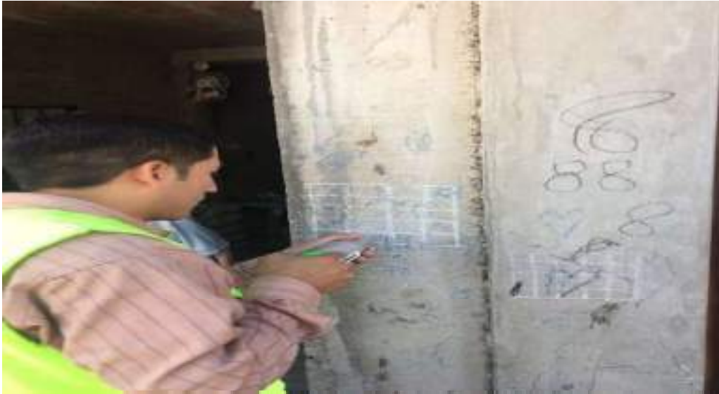
Figura N°1: Ensayo esclerometría en columna
